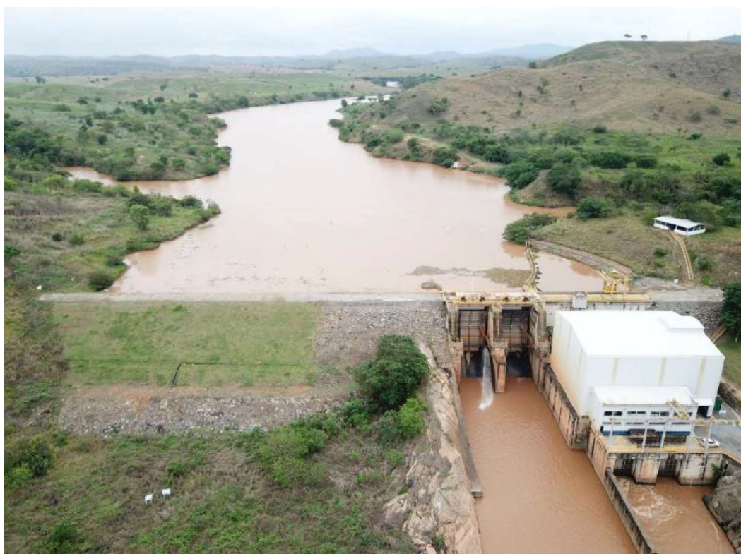
Figura 2. Vista geral da barragem da PCH Paiol
