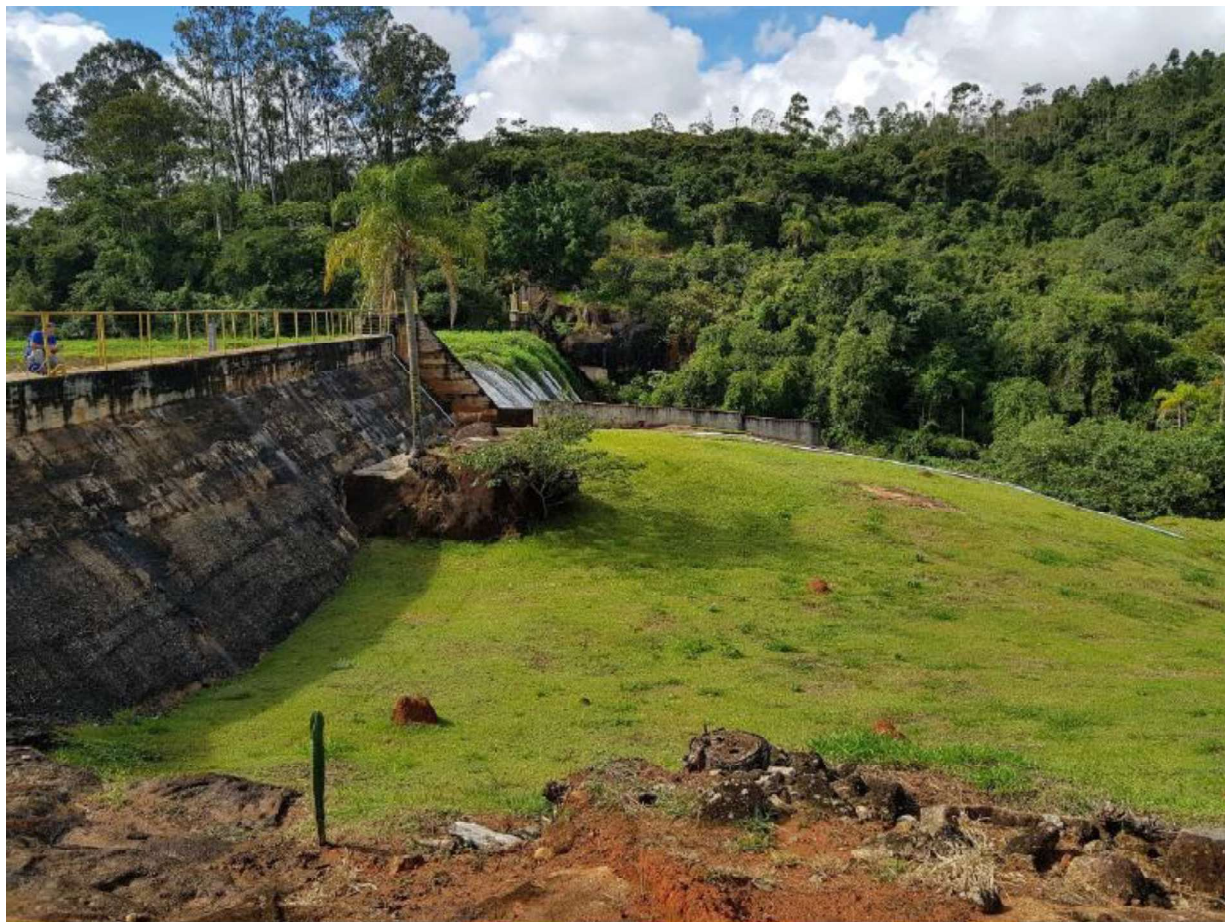
Figura 2. Vista geral da barragem da PCH Jaguari
