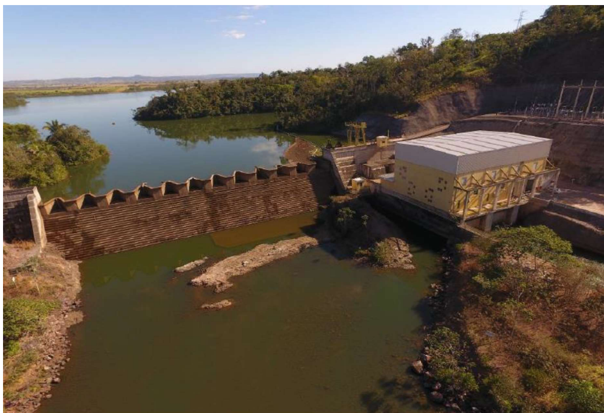
Figura 2. Vista geral da barragem da PCH Figueirópolis
