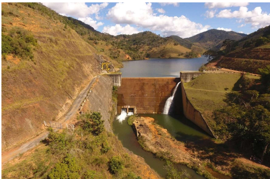
Figura 2. Vista geral da barragem da PCH Corrente Grande
