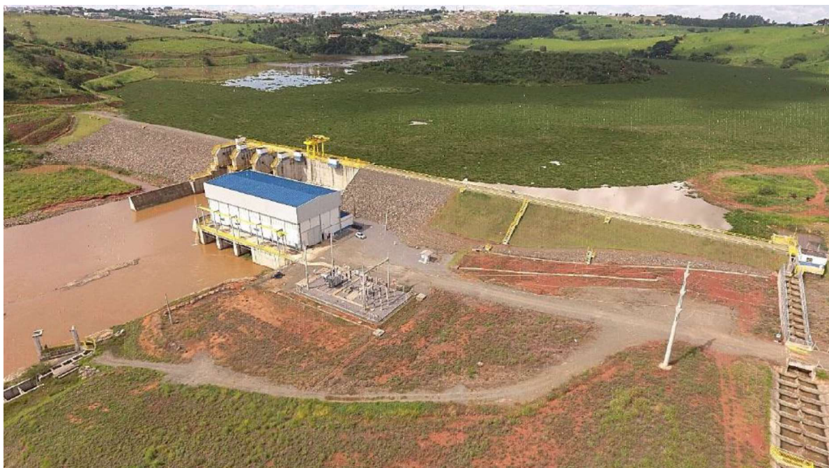
Figura 2. Vista geral da barragem da PCH BOA VISTA 2
