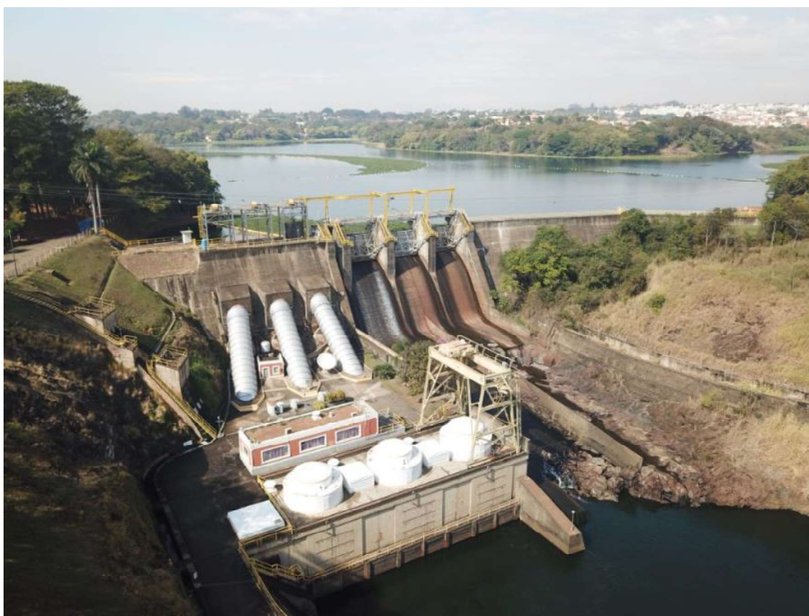
Figura 2. Vista geral da barragem da PCH Americana
