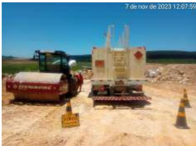
Figura 41 – Abastecimento de máquinas
