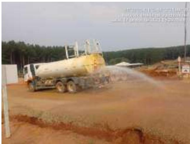
Figura 18 – Utilização do caminhão pipa para umectação
