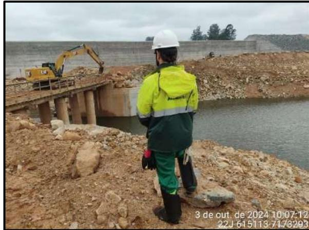
**Figura 38 – Remoção parcial de ponte de serviço.**
