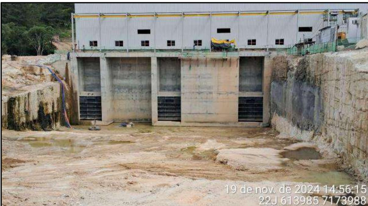
**Figura 9 – Vista da casa de jusante da casa de força e canal de restituição.**
