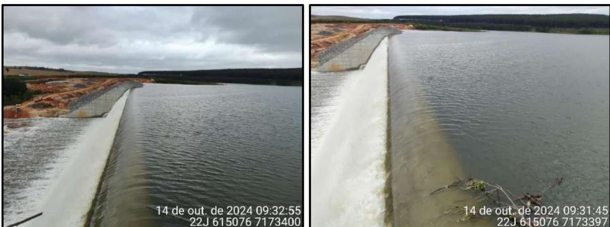
**Figura 29 – Condição do reservatório no dia 14/10 (cota 824,00 m).**
