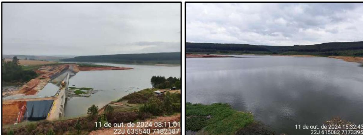
**Figura 26 – Condição do reservatório no dia 11/10 (cota 818,20 m).**
