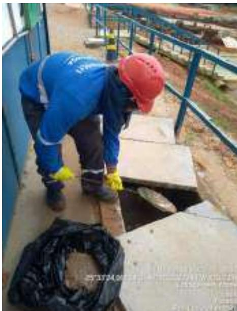
Figura 09 – Limpeza do sistema – CX Gordura
