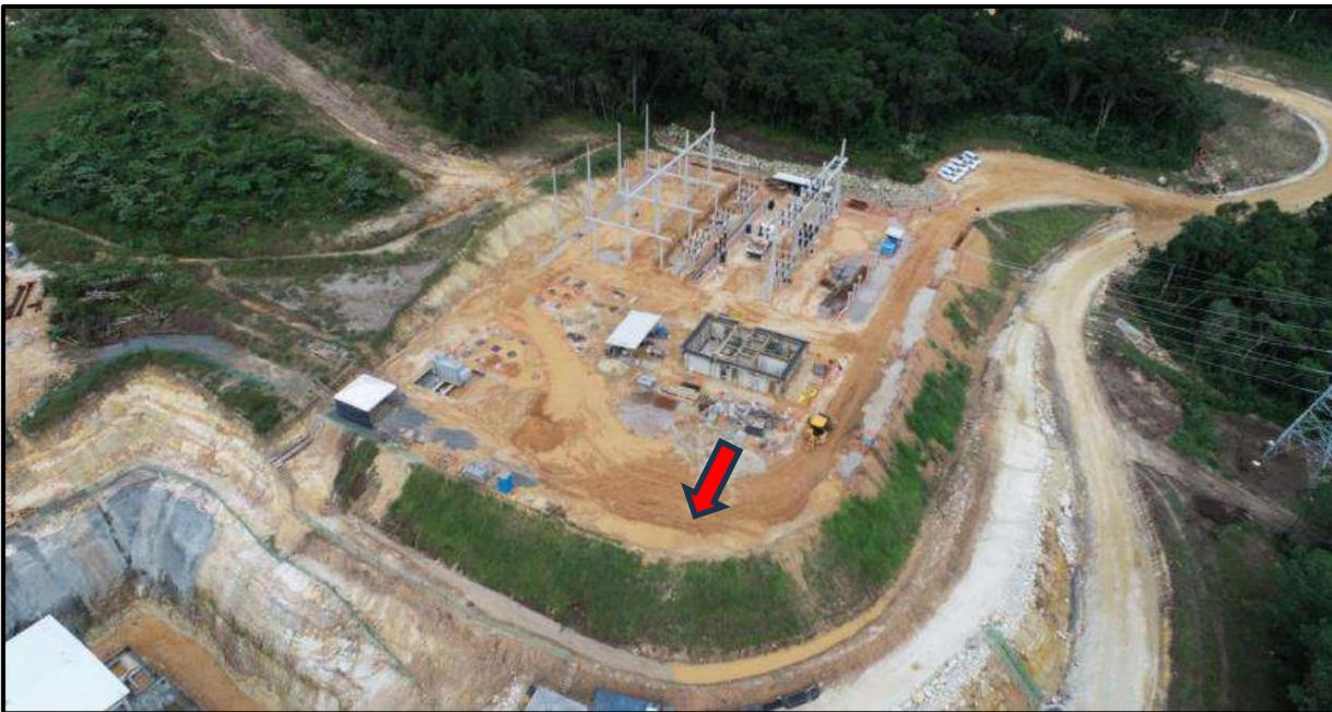
**Figura 138 – Tratamentos do talude da região da casa de força e subestação.**
