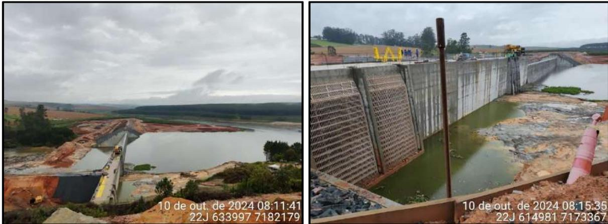
**Figura 25 – Condição do reservatório às 08h do dia 10/10 (cota 816,50 m).**
