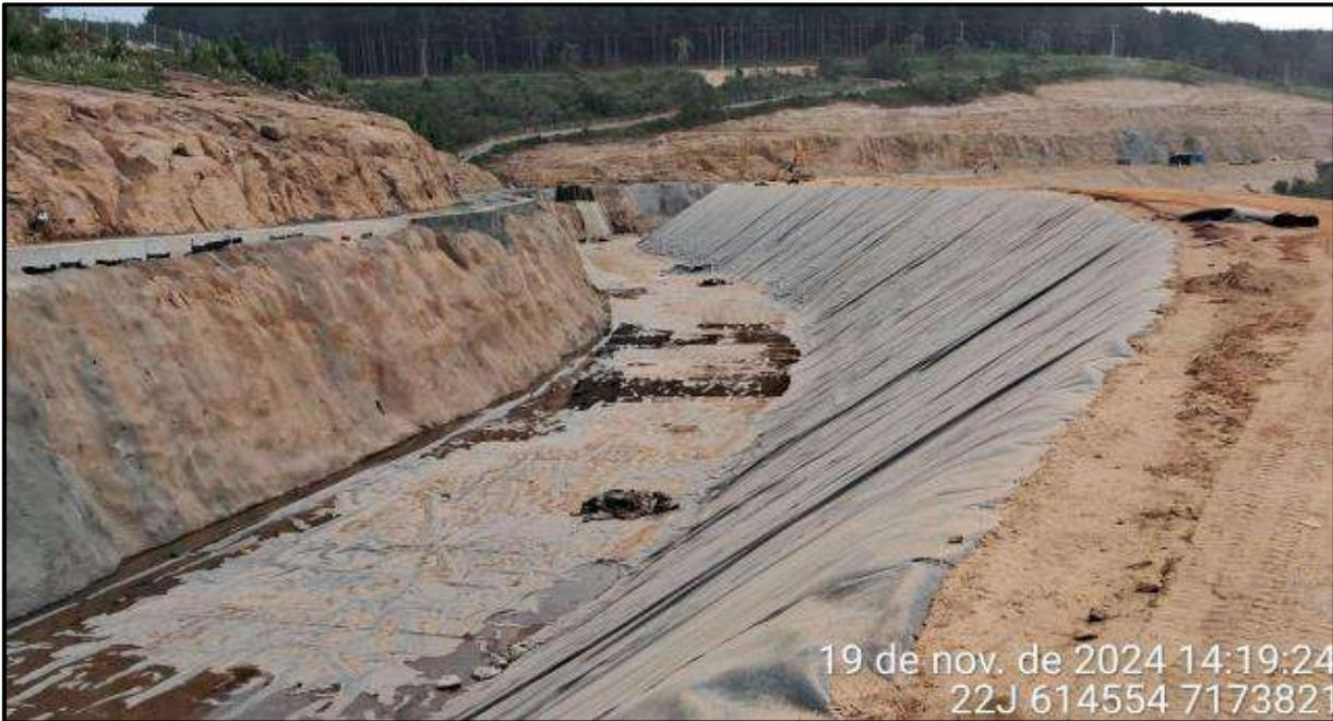
**Figura 6 – Canal de adução – aplicação de transição, manta geotêxtil e manta PEAD.**
