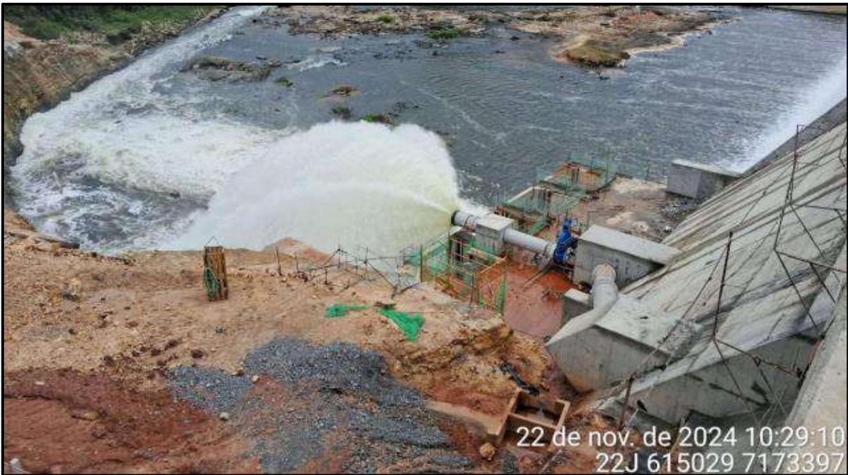
**Figura 3 – Registros fotográficos do reservatório consolidado, barramento e dispositivo de vazão sanitária.**
