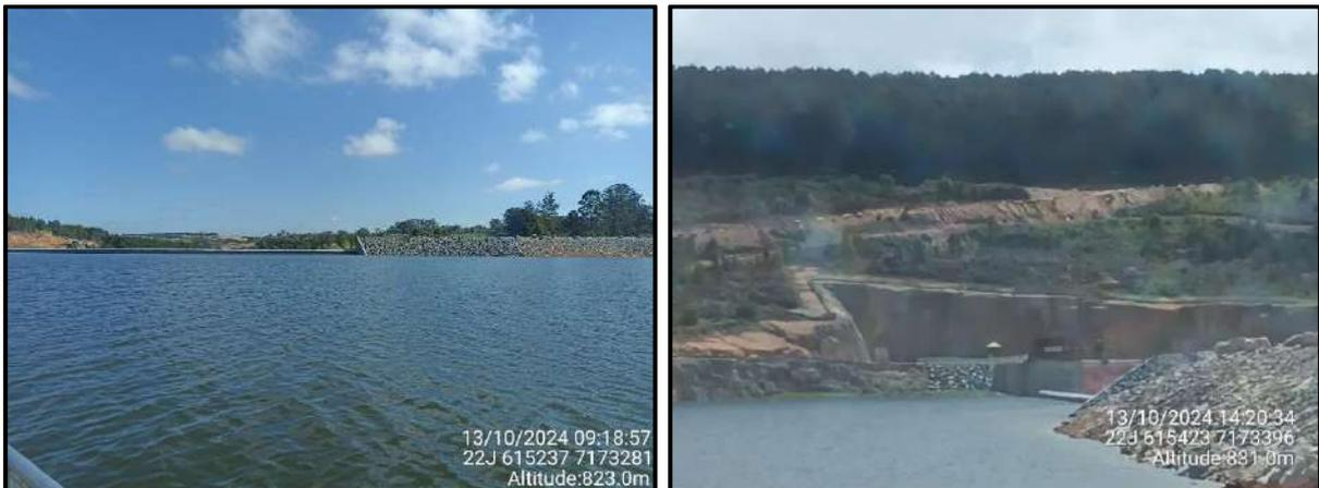
**Figura 28 – Condição do reservatório no dia 13/10 (cota 823,00 m).**
