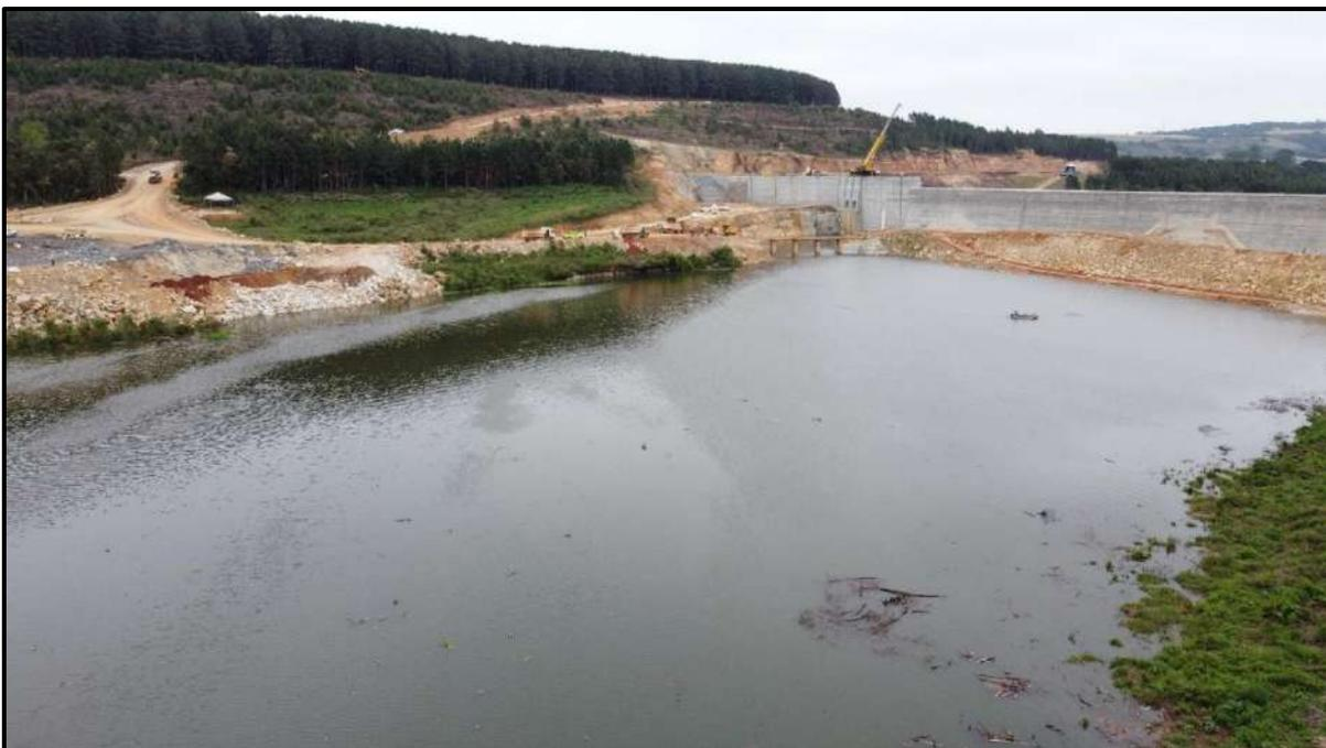
**Figura 17 – Condição do reservatório às 14h do dia 03/10 (cota 807,50 m).**
