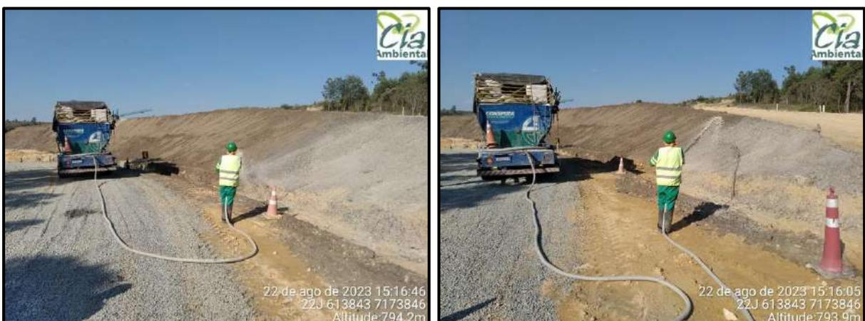
**Figura 137 – Execução de hidrossemeadura nos taludes de acesso à subestação.**
