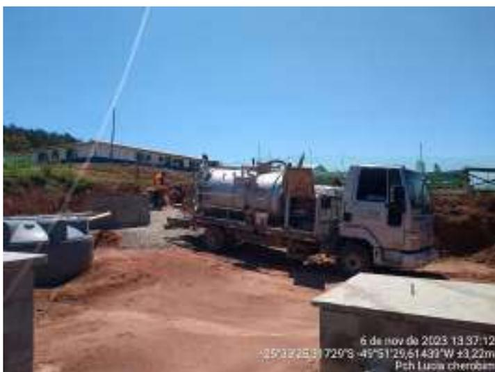
Figura 13 – Limpeza do caixa gradeada - ETE
