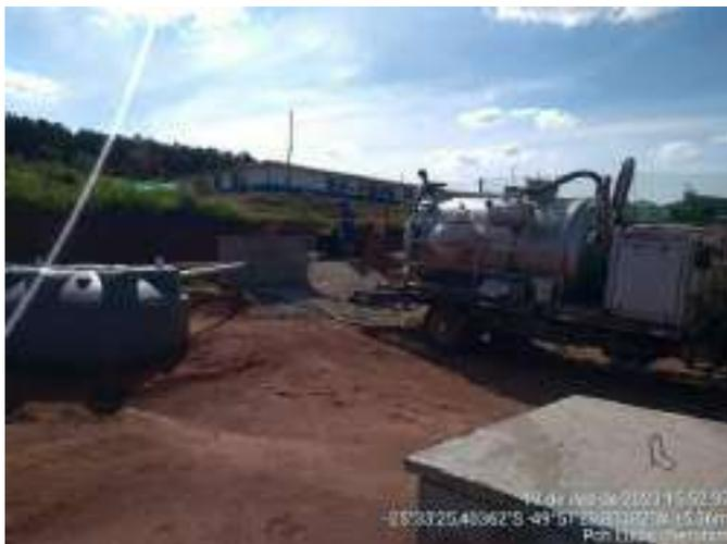
Figura 11 – Limpeza da caixa gradeada - ETE
