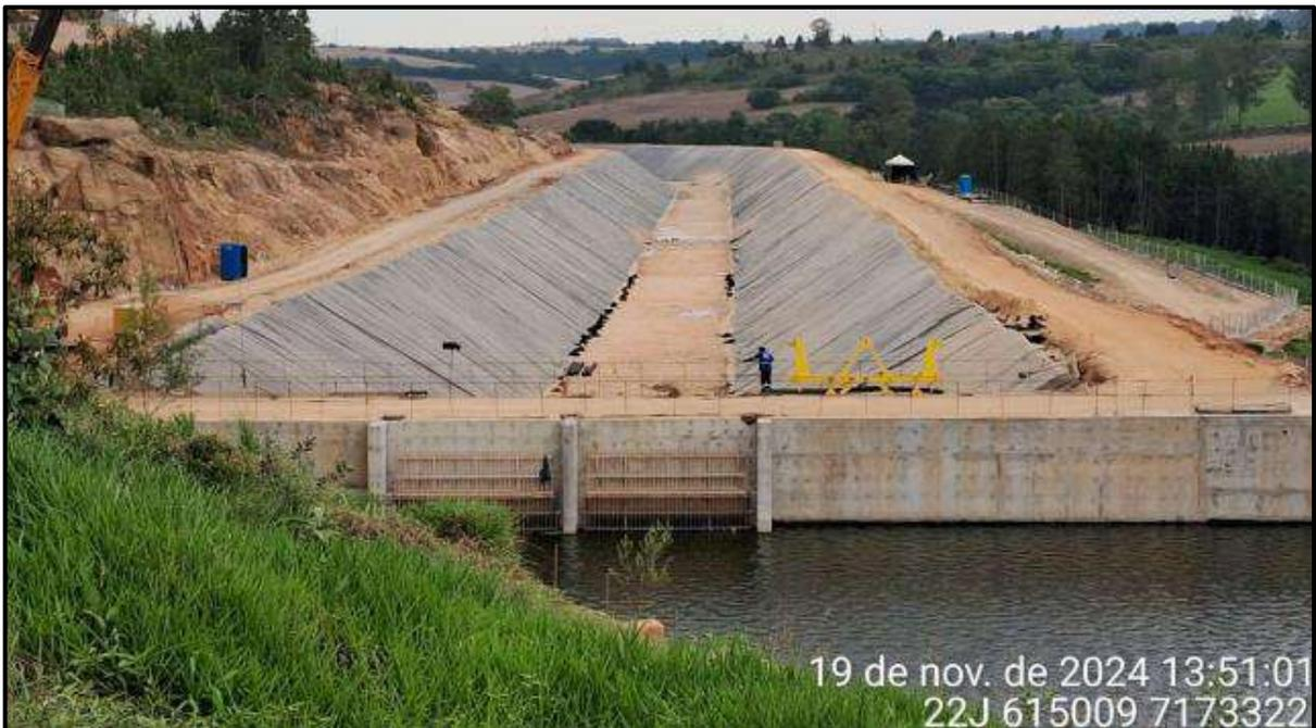
**Figura 5 – Canal de adução em fase final de execução.**
