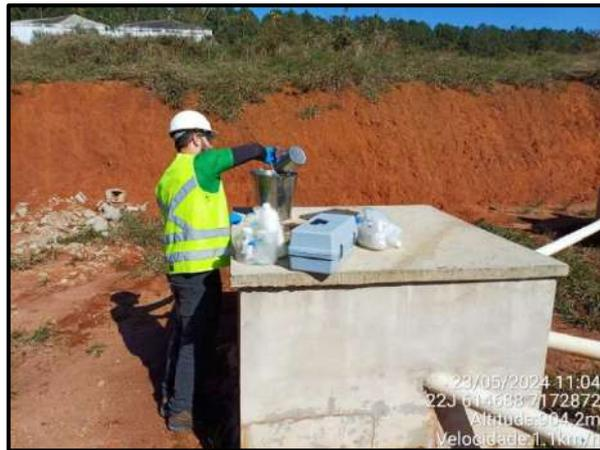
**Figura 83 - Coleta de amostras de efluentes na entrada e saída do sistema da estação de tratamento de esgoto (ETE).**
