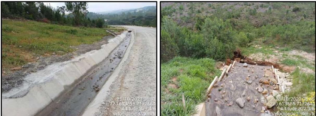
**Figura 136 – Implantação de sistemas de drenagem junto ao acesso.**
