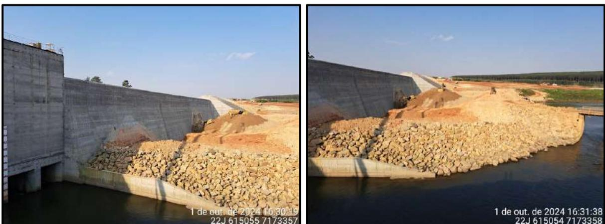
**Figura 36 – Rebaixamento da ensecadeira de montante.**
