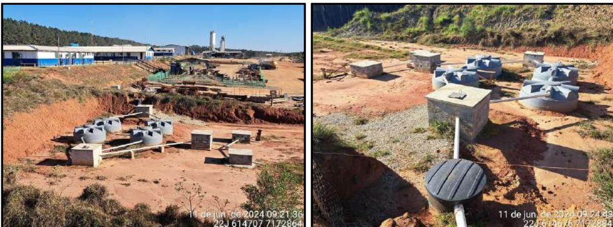
**Figura 73 – Estação de tratamento de efluentes instalada no canteiro de obras.**
