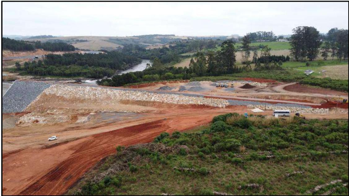
Figura 40 – Conclusão de enrocamento na ombreira direita do barramento.
