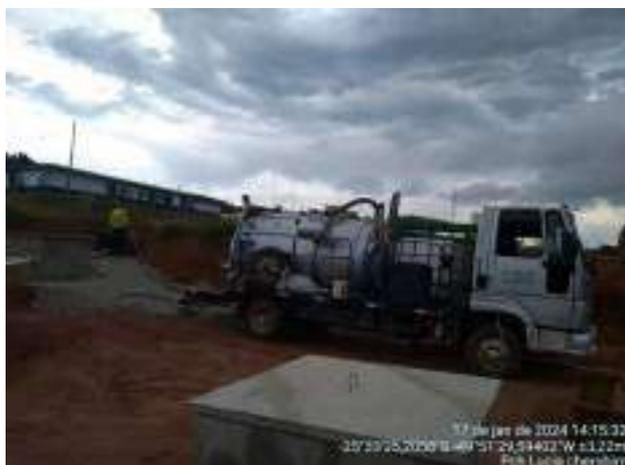
Figura 14 – Sucção da caixa gradeada - ETE
