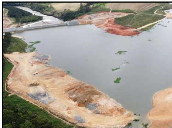
**Figura 39 – Rebaixamento e nivelamento de bota-foras.**
