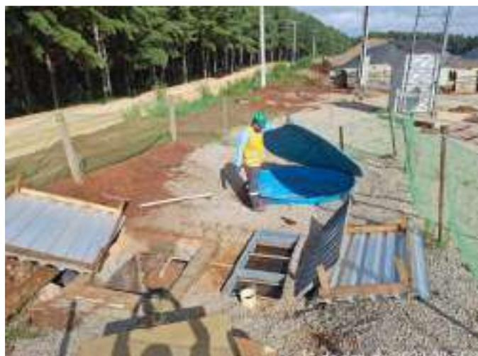
Figura 14 – Inspeção – Caixa SAO
