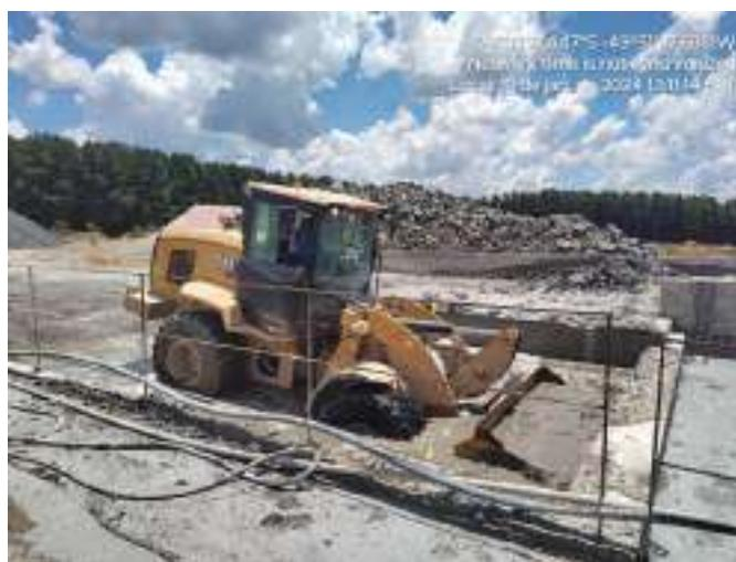
Figura 13 – Decantador industrial - - retirada de concreto
