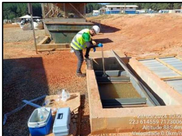
**Figura 84 - Coleta de amostras de efluentes na caixa separadora de água e óleo da oficina mecânica.**
