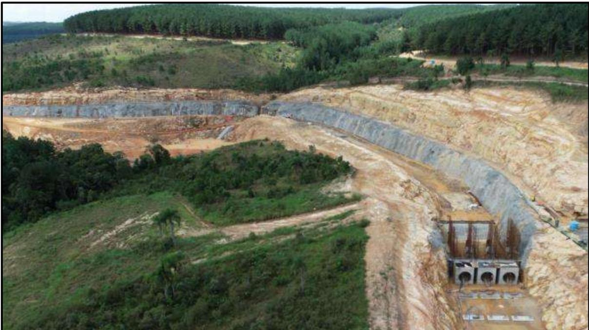
**Figura 140 – Tratamento com concreto projetado nos taludes de rocha do canal de adução.**
