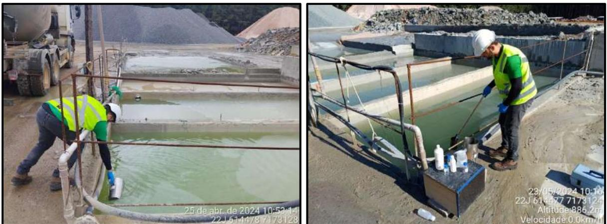
**Figura 87 - Coleta de amostra de efluentes no decantador industrial.**
