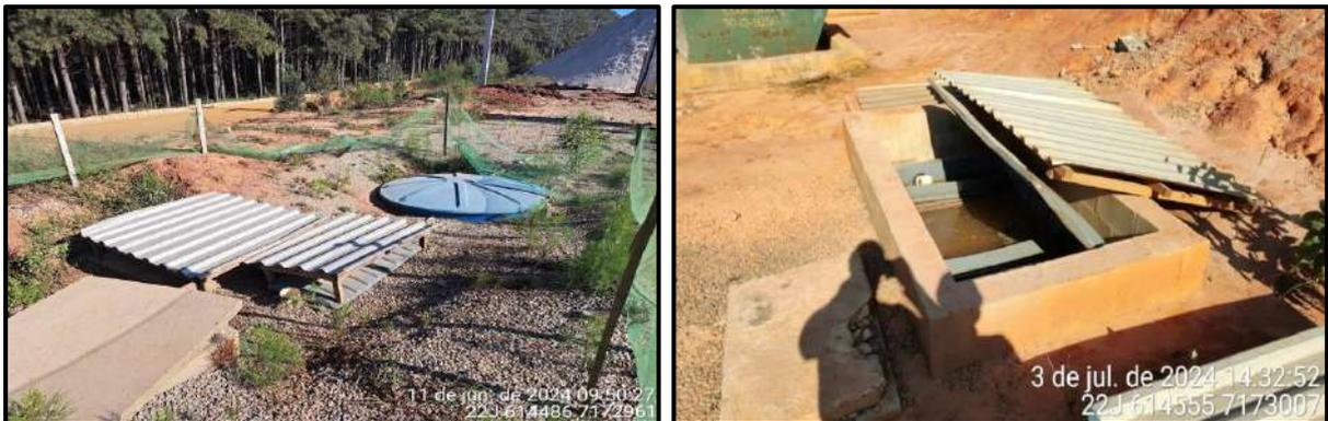
**Figura 75 – Inspeções de caixas separadoras de água e óleo.**
