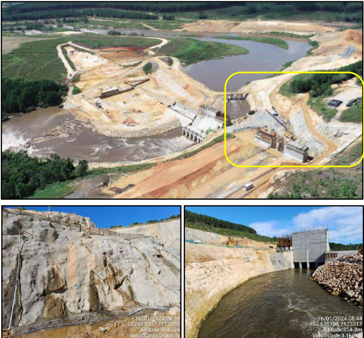
**Figura 139 – Tratamento com concreto projetado nos taludes de rocha do barramento.**
