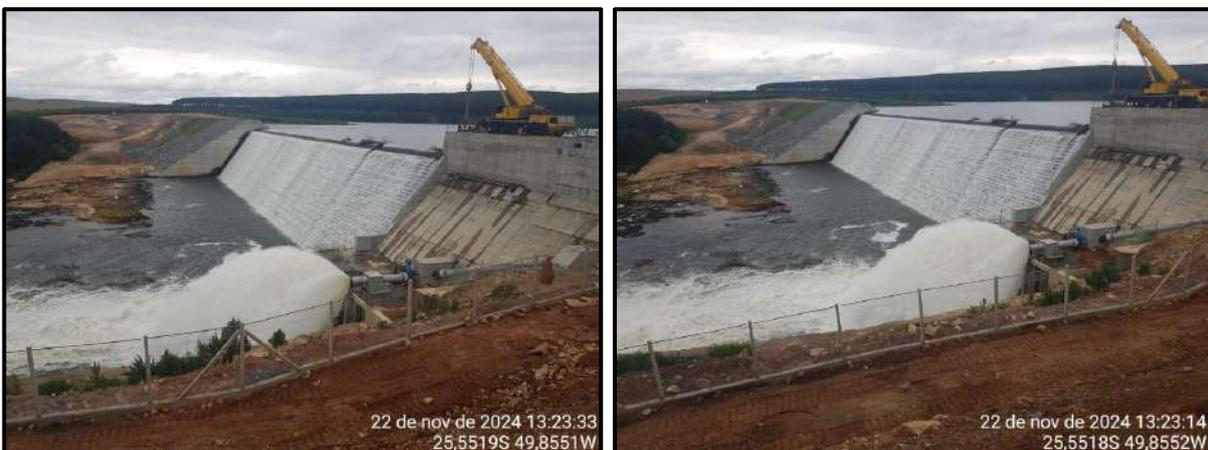
**Figura 7 – Abertura completa do dispositivo de vazão sanitária.**
