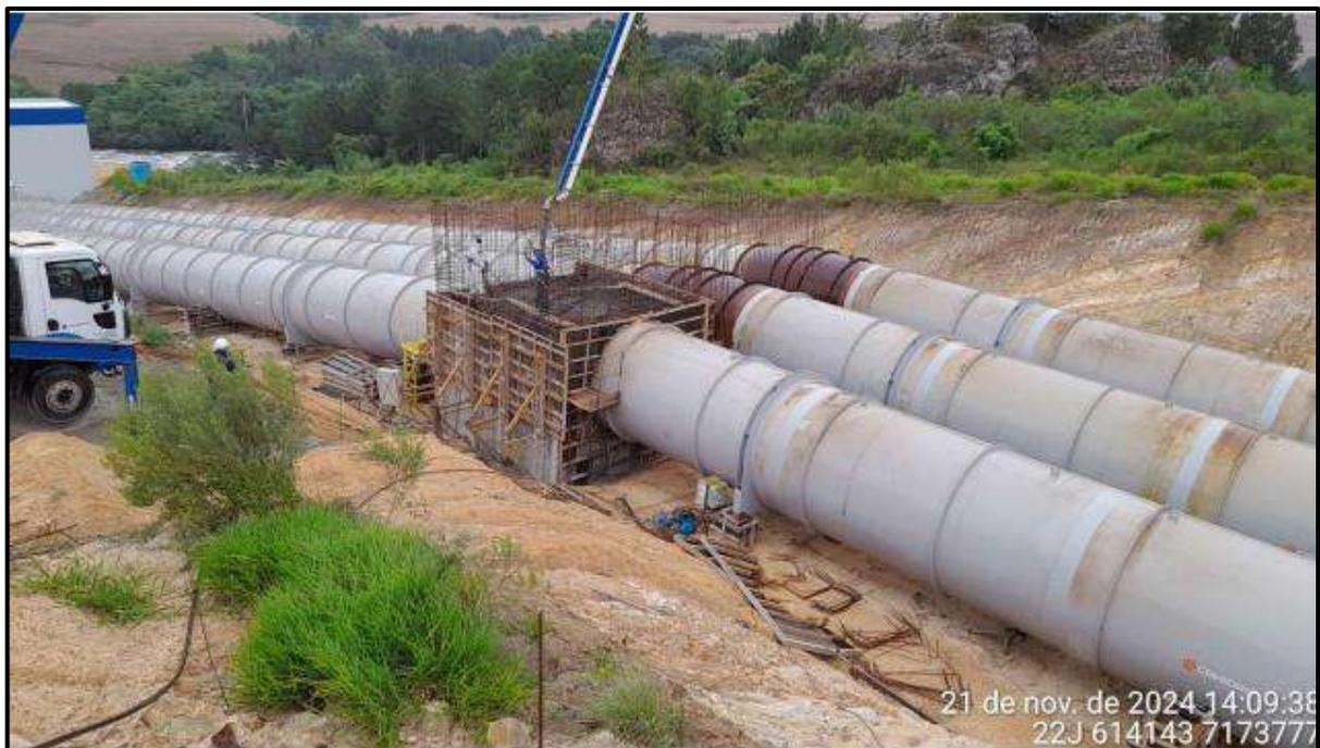
**Figura 8 – Vistas de montante da câmara de carga e tomada d'água de alta pressão e condutos forçados.**
