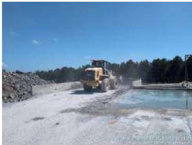
Figura 10 – Decantador industrial - - retirada de concreto
