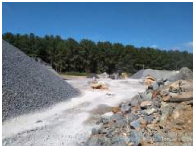
Figura 02 – Área de armazenamento de concreto
