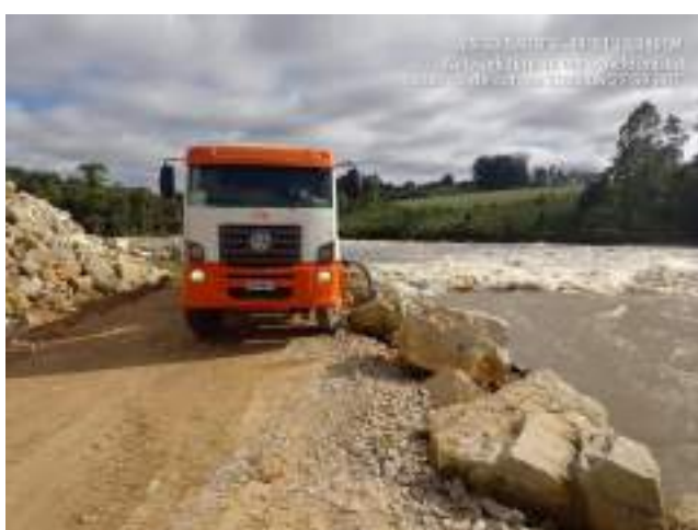
Figura 15 – Captação de água superficial
