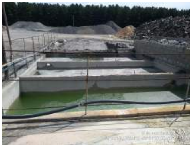
Figura 10 – Decantador industrial
