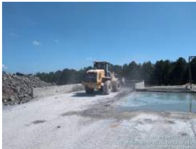
Figura 10 – Decantador industrial - - retirada de concreto
