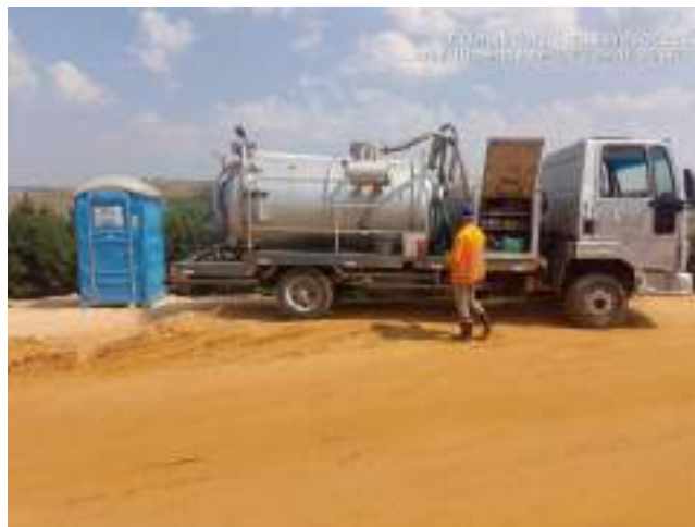
Figura 08 – Sucção dos efluentes dos banheiros químicos
