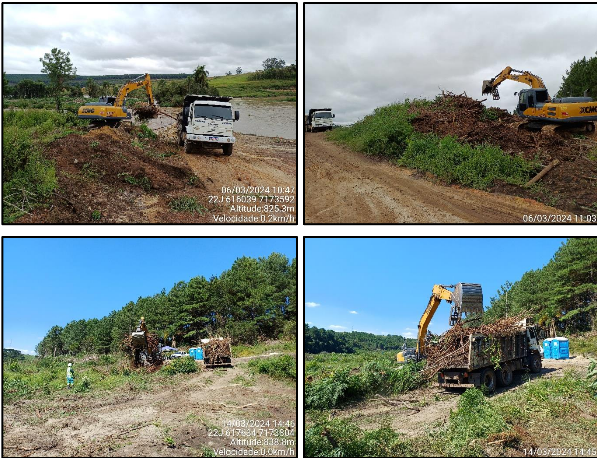
Figura 46 - Execução das atividades de limpeza vegetal nas áreas do futuro reservatório realizada no mês de março de 2024.
