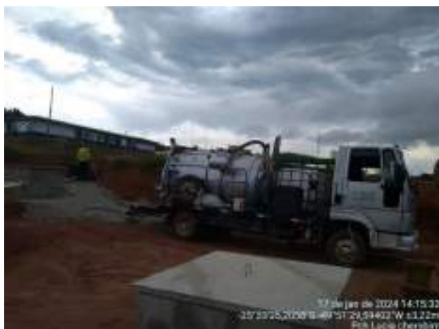
Figura 14 – Sucção da caixa gradeada - ETE
