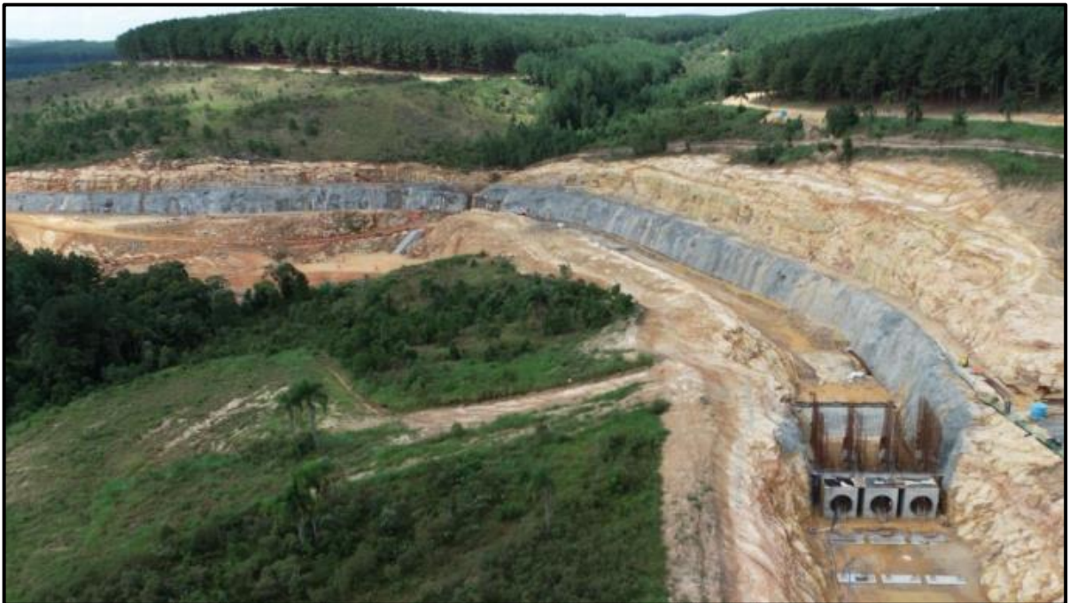
Figura 68 – Tratamento com concreto projetado nos taludes de rocha do canal de adução.
