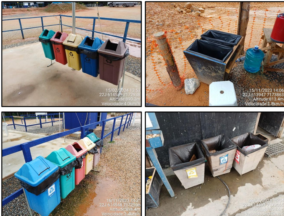
Figura 12 - Inspeção nos coletores de resíduos das frentes de serviço e no canteiro de obra.
