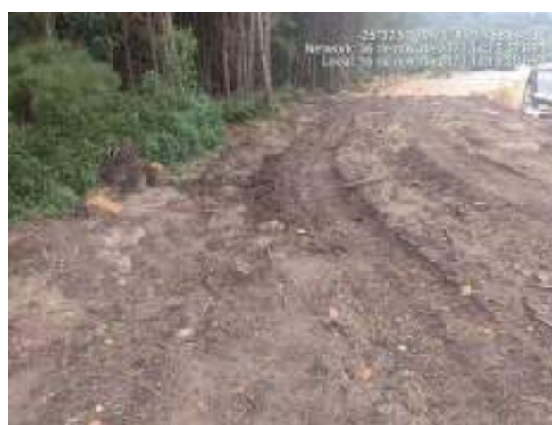
Figura 26 - Acompanhamento de intervenções corretivas
