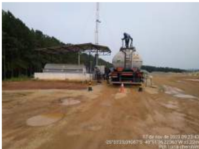
Figura 43 – Abastecimento de diesel - tanque de combustível
