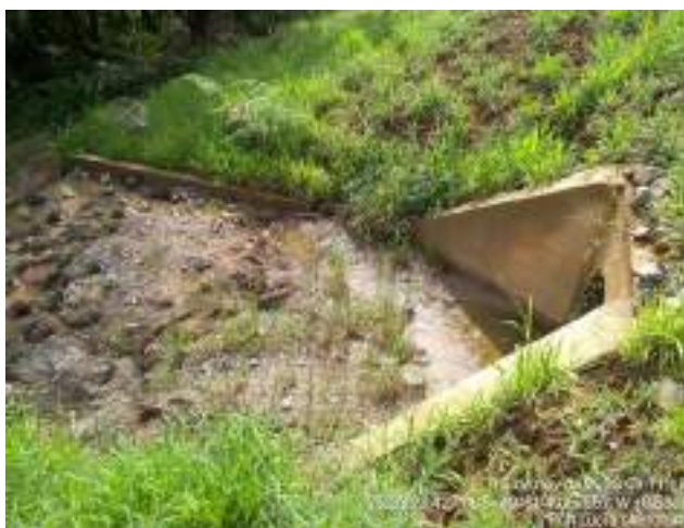
Figura 23 – Acompanhamento de drenagem
