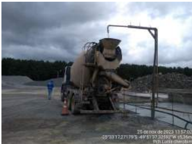
Figura 09 – Decantador industrial - - retirada de água
