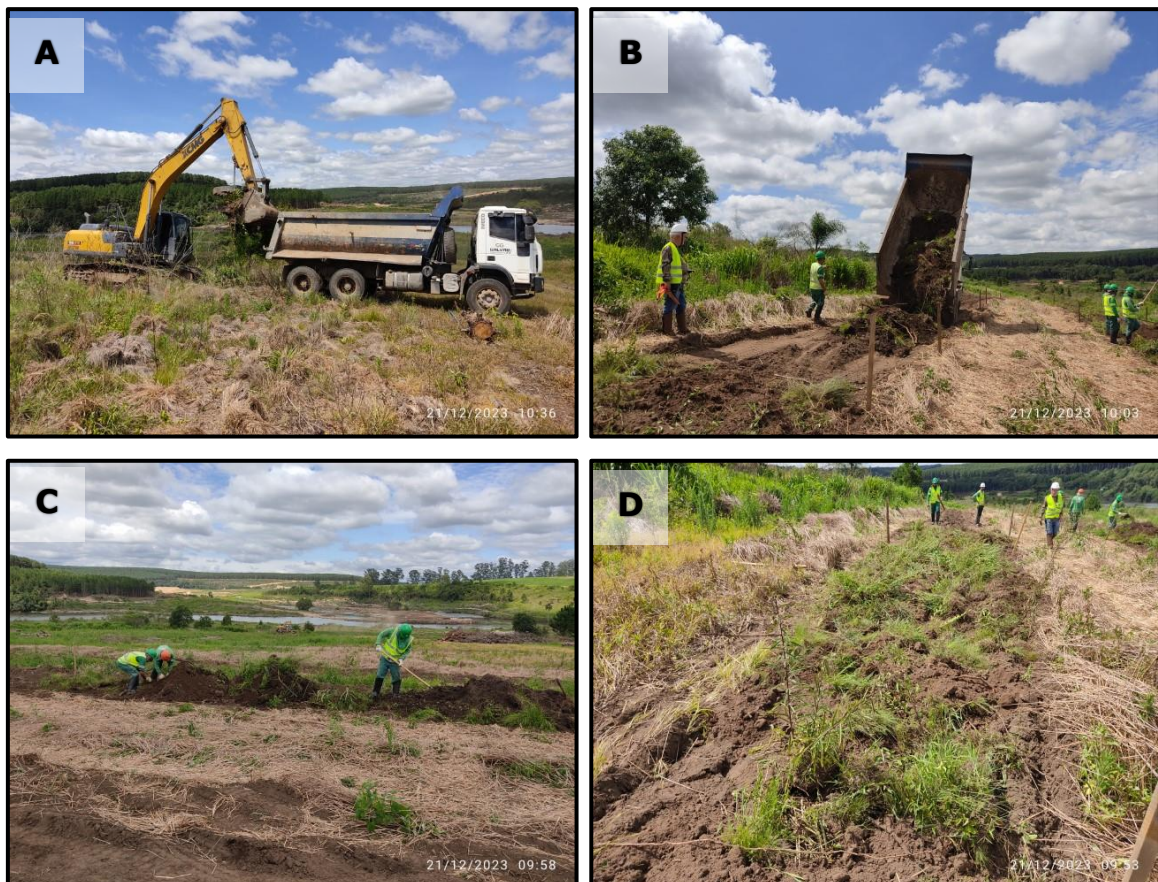
Figura 50 - Metodologia de transposição de topsoil .
