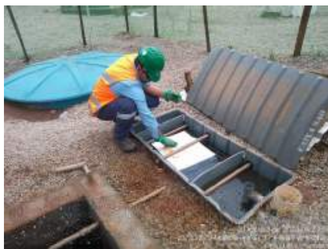
Figura 08 – Limpeza de CX SAO
