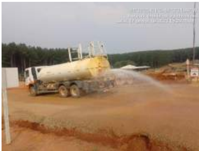
Figura 18 – Utilização do caminhão pipa para umectação
