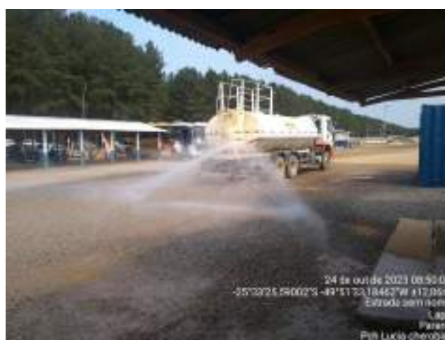
Figura 16 – Utilização do pipa para umectação
