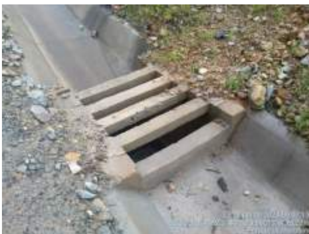
Figura 30 – Acompanhamento de drenagem
