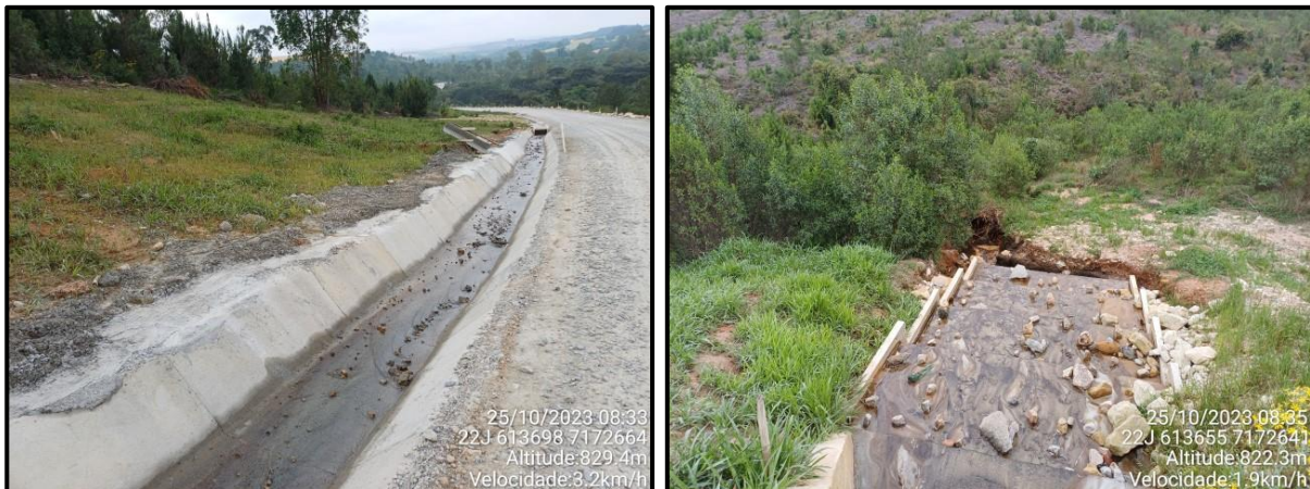
Figura 64 – Implantação de sistemas de drenagem junto ao acesso.
