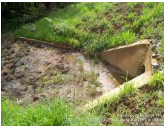
Figura 27 – Acompanhamento de drenagem
