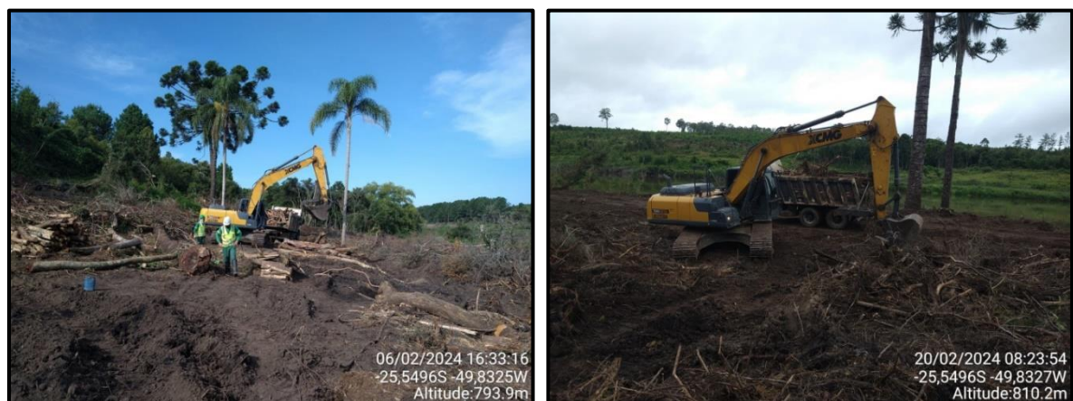
Figura 45 - Execução das atividades de limpeza vegetal nas áreas do futuro reservatório realizada no mês de fevereiro de 2024.
