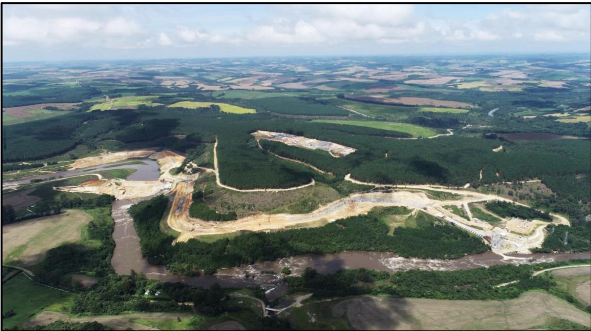
Figura 2 – Vista aérea da PCH Lúcia Cherobim (PCH e canteiro de obras).
