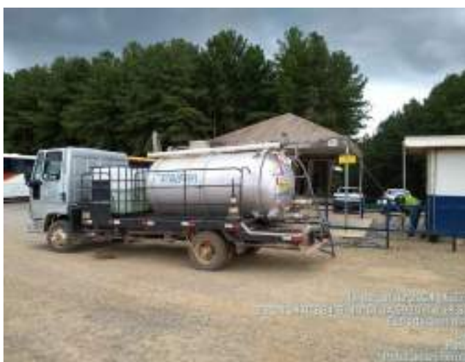
Figura 11 – Sucção da caixa coletora da portaria
