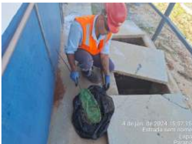
Figura 16 – Limpeza caixa de gordura
