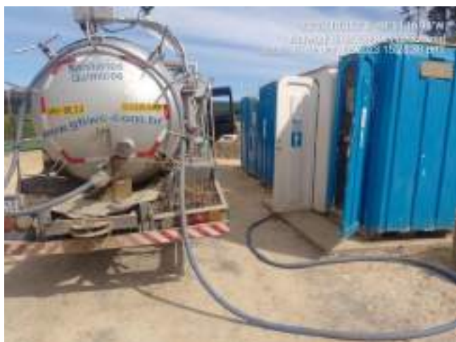
Figura 07 – Caminhão de transporte de efluentes
