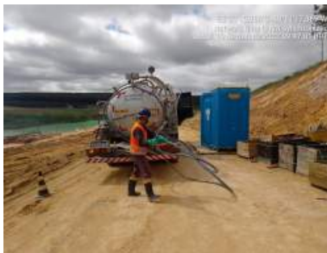
Figura 06 – Sucção dos efluentes dos banheiros químicos
