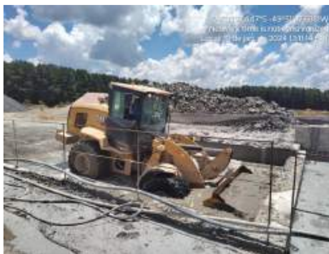
Figura 13 – Decantador industrial - - retirada de concreto
