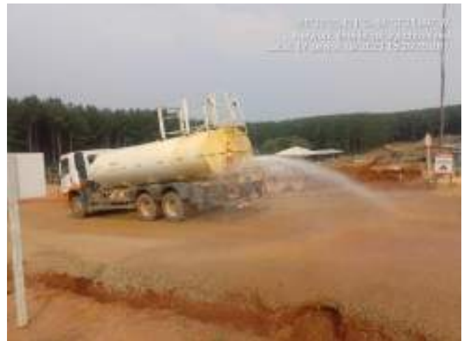
Figura 18 – Utilização do caminhão pipa para umectação
