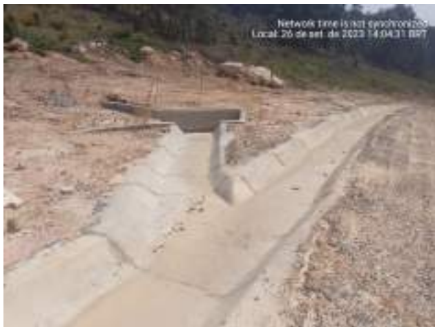
Figura 23 – Acompanhamento de drenagem
