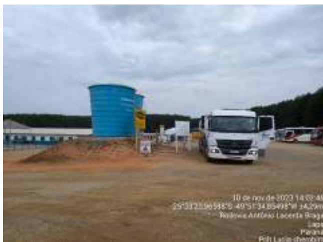
Figura 21 – Abastecimento de água potável no canteiro
