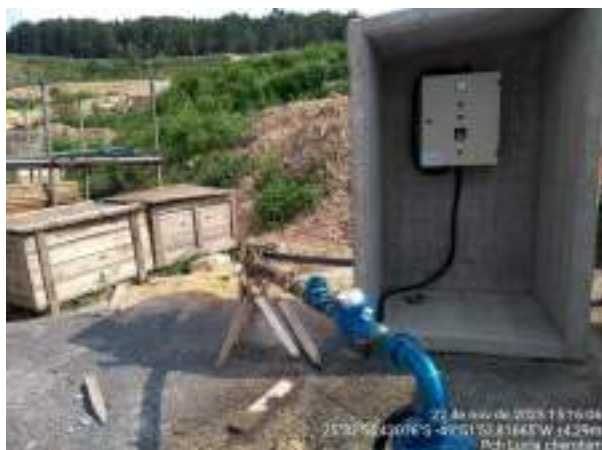
Figura 23 – Instalação do poço SE
