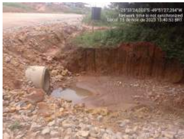
Figura 28 - Acompanhamento de bueiros
