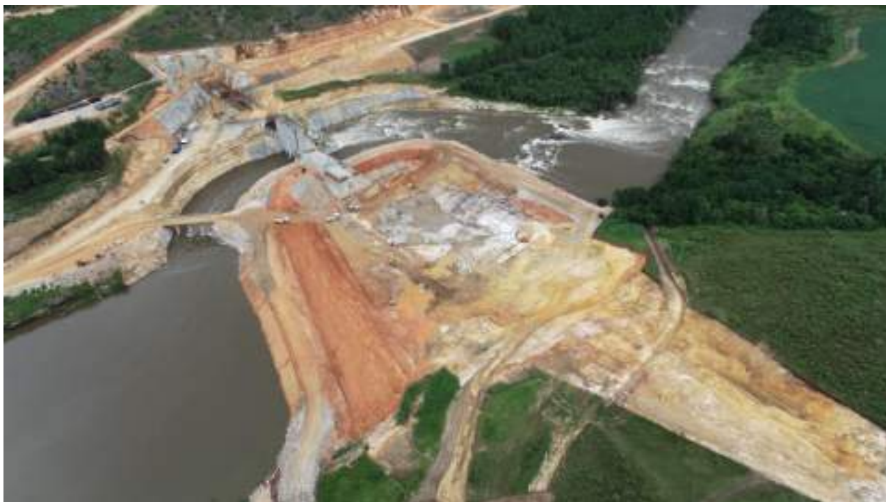
Figura 01 – Visão aérea da barragem – enseadeira segunda fase
