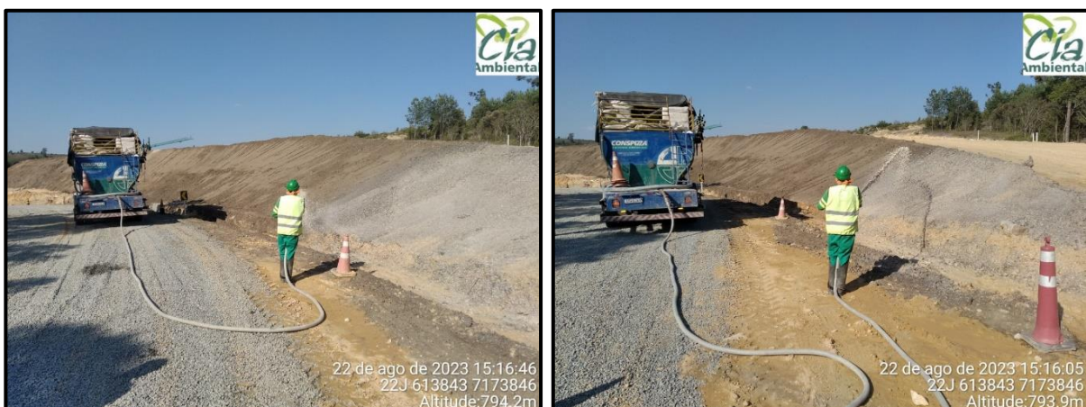
Figura 65 – Execução de hidrossemeadura nos taludes de acesso à subestação.
