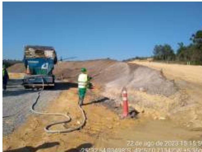
Figura 27 – 2ª atividade de Hidrossemeadura (08.23)
