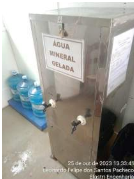
Figura 17 – Controle de limpeza e laudo de potabilidade
