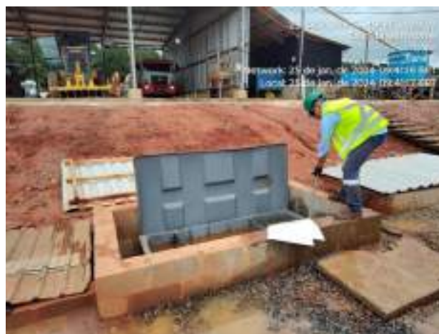
Figura 15 – Limpeza da caixa SAO
