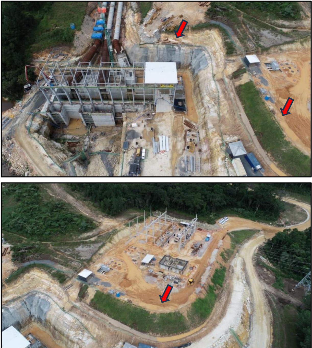
Figura 66 – Tratamentos do talude da região da casa de força e subestação.
