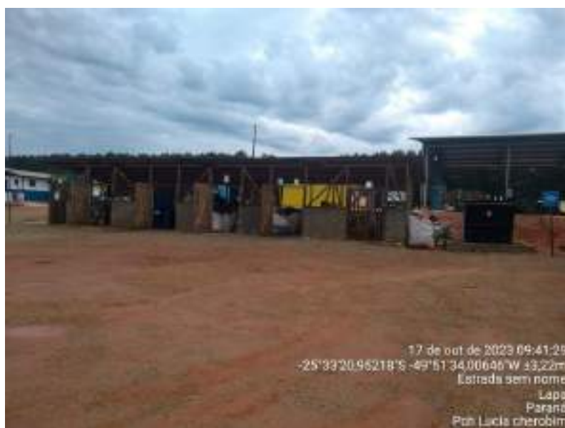
Figura 03 – Baia de resíduos
