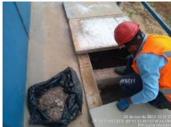
Figura 12 – Limpeza da caixa de gordura
