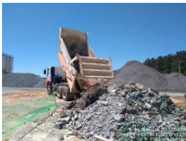
Figura 02 – Área de armazenamento de concreto
