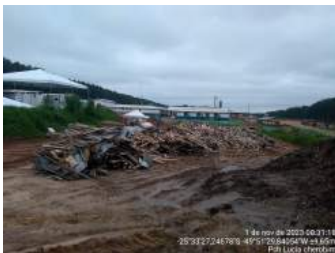
Figura 01 – Área de armazenamento de madeira
