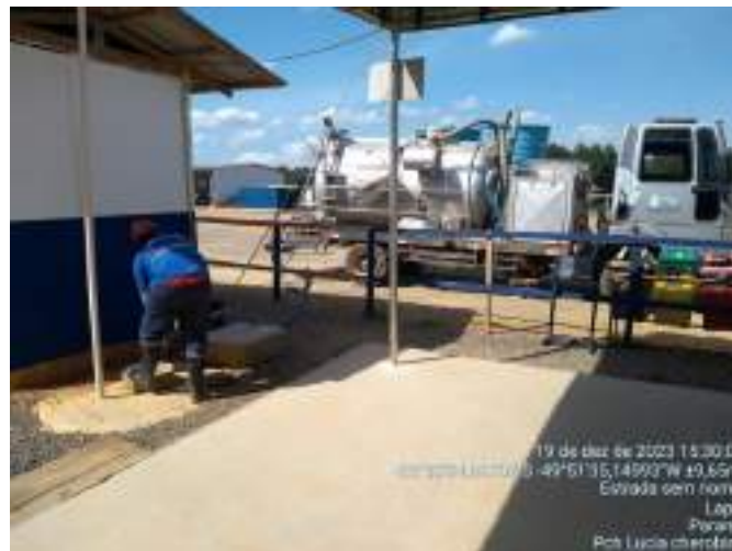
Figura 12 – Limpeza da caixa coletora portaria
