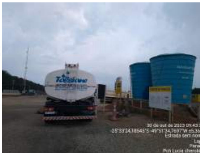
Figura 19 – Abastecimento de água potável no canteiro
