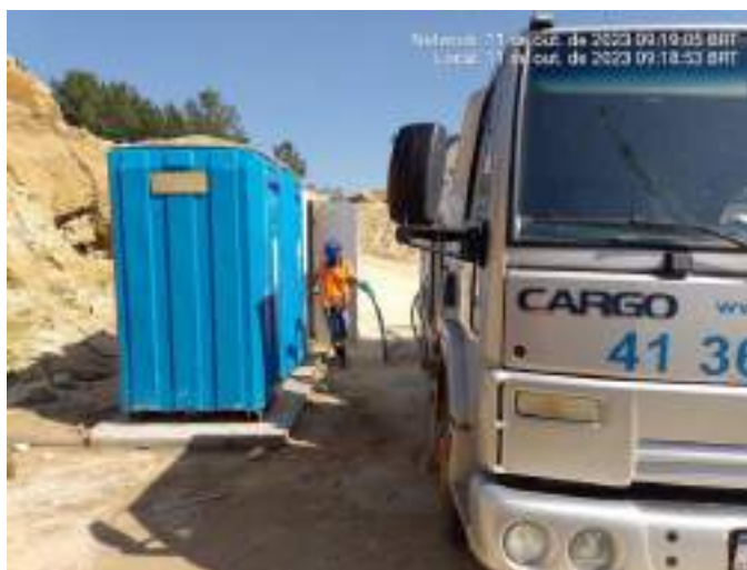
Figura 05 – Sucção dos efluentes dos banheiros químicos
