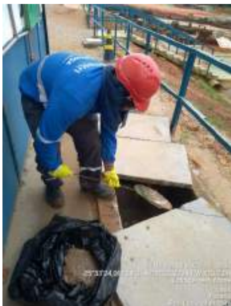
Figura 09 – Limpeza do sistema – CX Gordura
