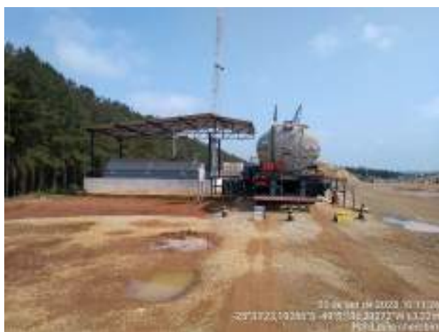
Figura 38 – Abastecimento de diesel - tanque de combustível
