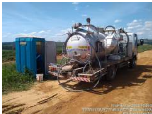
Figura 08 – Sucção dos efluentes dos banheiros químicos
