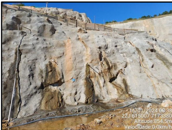
Figura 67 – Tratamento com concreto projetado nos taludes de rocha do barramento.
