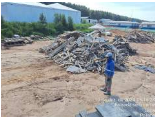
Figura 01 – Área de armazenamento de madeira
