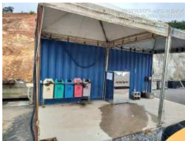
Figura 05 – Coleta dos resíduos nas frentes de serviço
