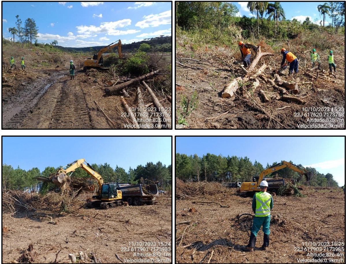
Figura 40 - Execução das atividades de limpeza vegetal da margem esquerda (futuro reservatório) realizada no mês de outubro de 2023.
