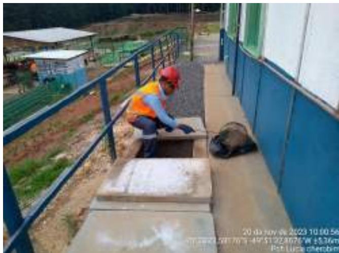
Figura 11 – Limpeza da caixa de gordura
