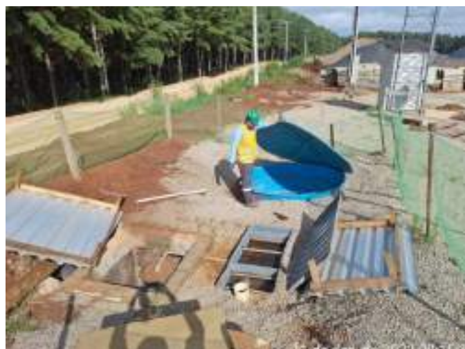
Figura 14 – Inspeção – Caixa SAO
