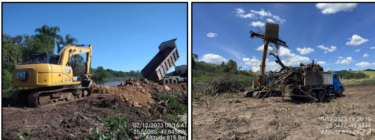
Figura 43 - Execução das atividades de limpeza vegetal nas áreas do futuro reservatório realizada no mês de dezembro de 2023.
