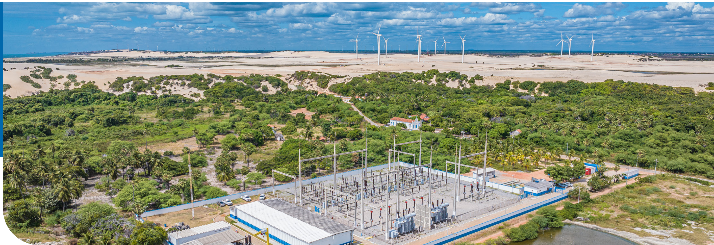
Complexo Eólico de Aracati, no Ceará.
