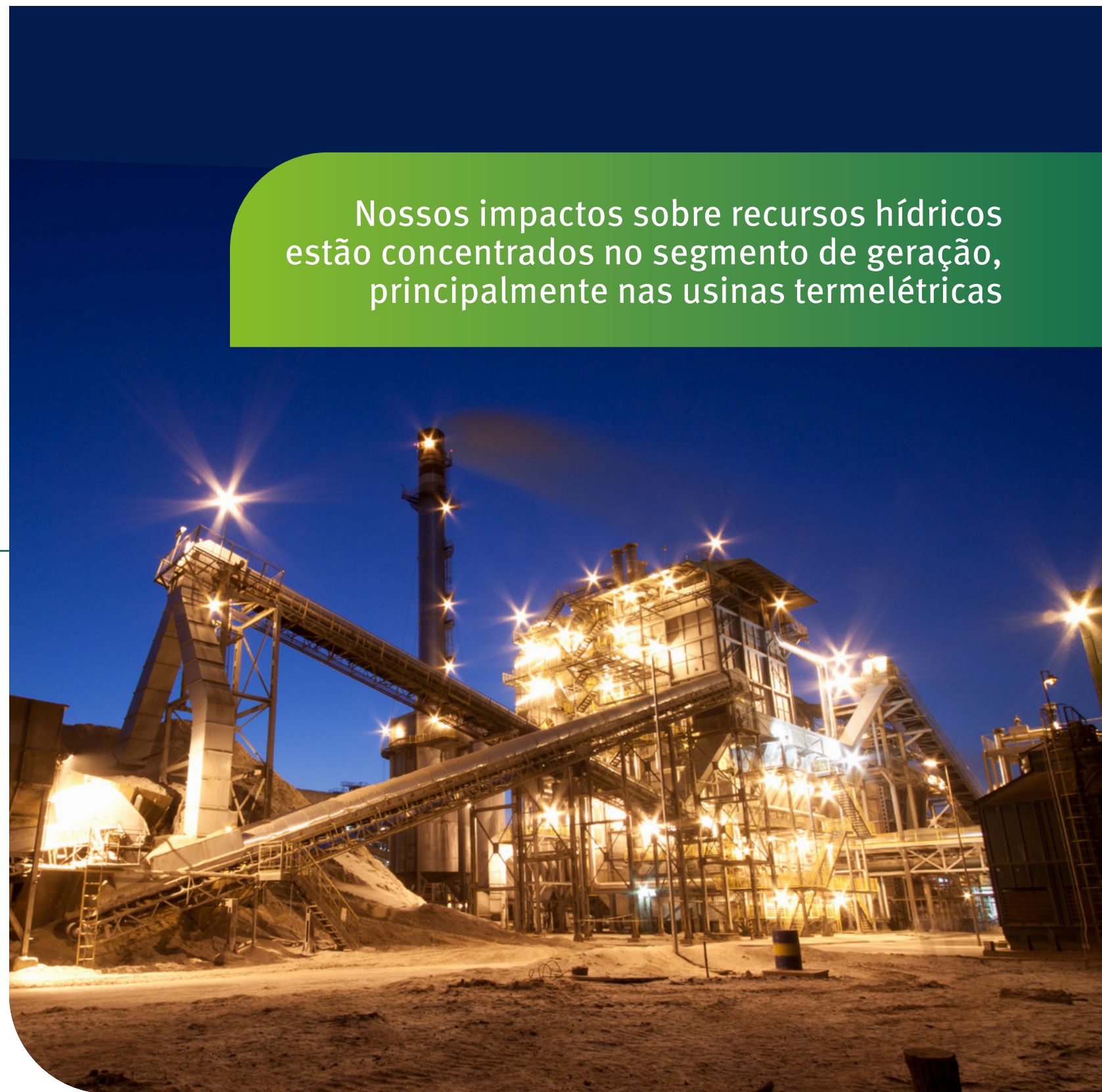
Usina de biomassa em Pirassununga (SP).
