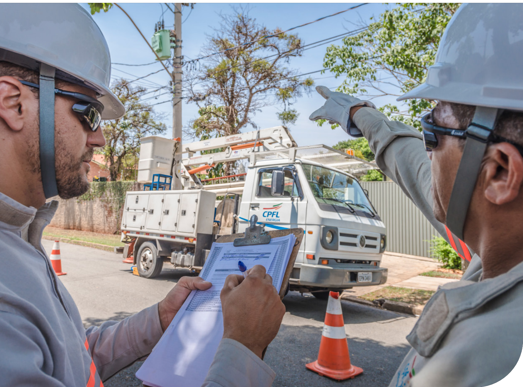
Avaliação de riscos antes da execução de trabalho em Campinas (SP).
