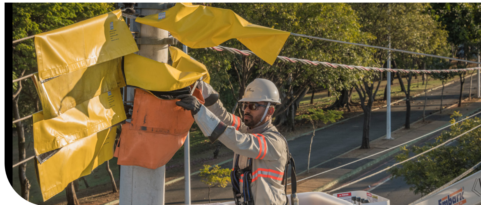
Manutenção em rede da CPFL Piratininga (SP).
