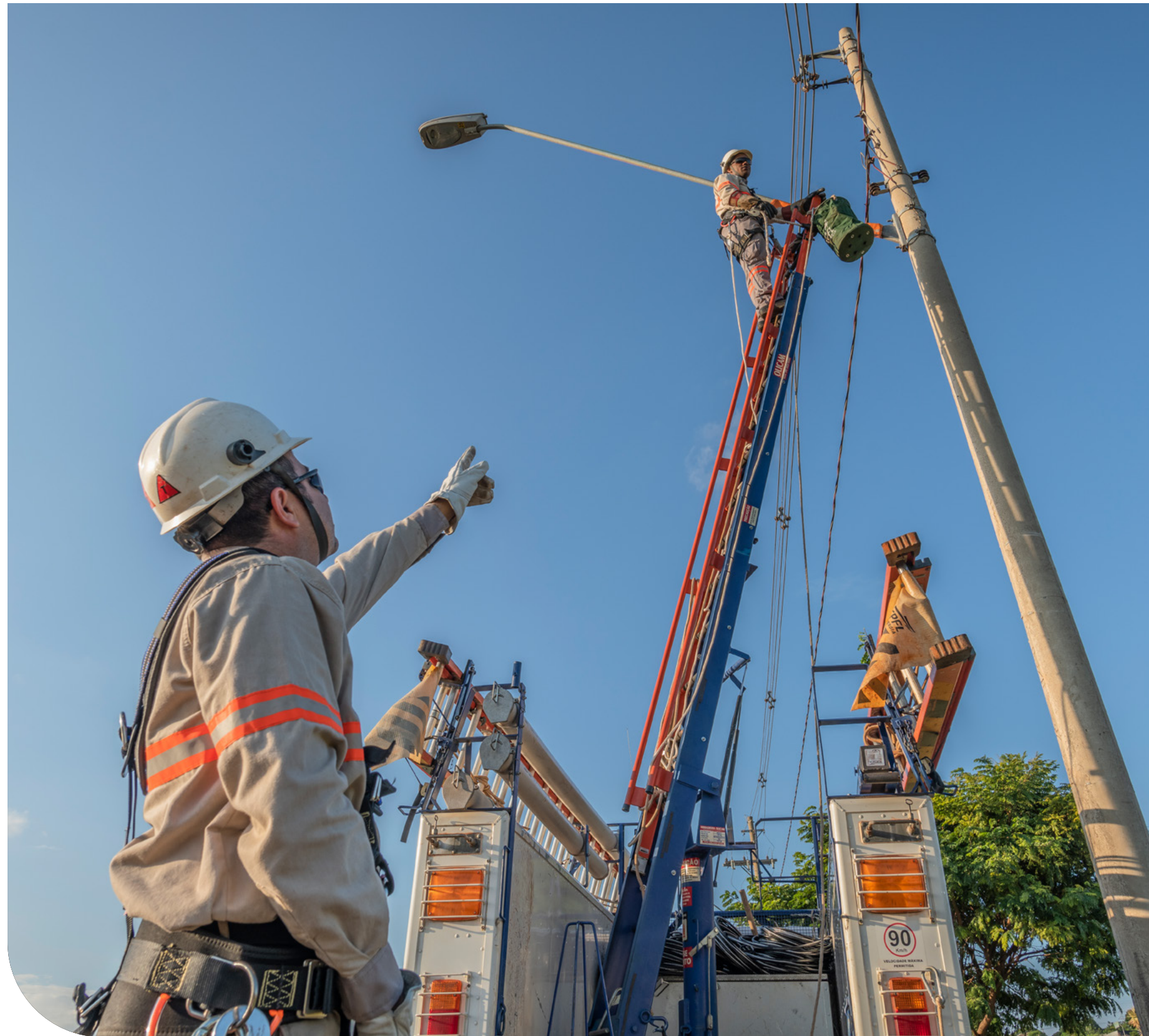
Manutenção em rede da CPFL Santa Cruz (SP).
