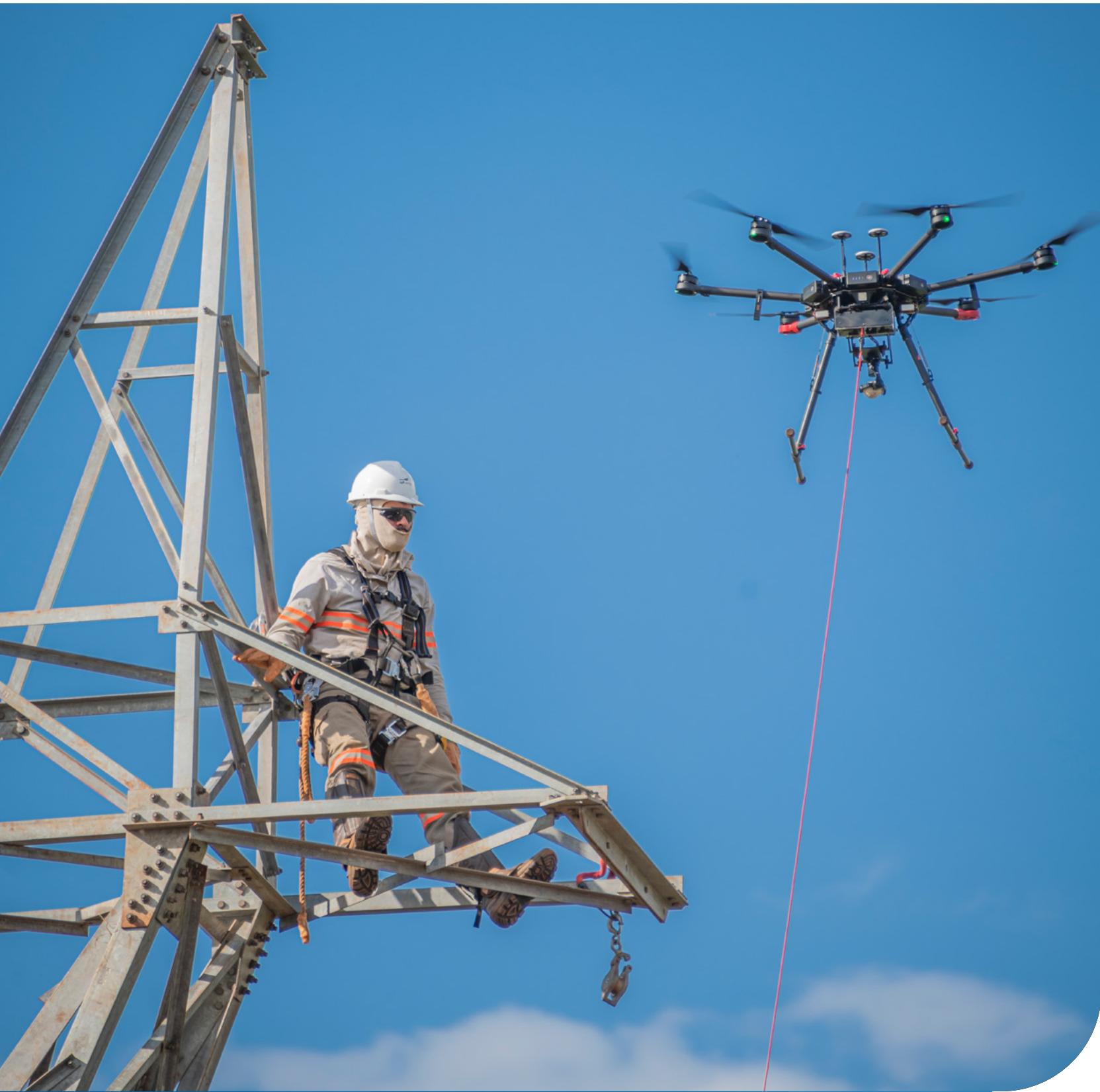
Operation of CPFL Soluções in Araraquara (SP).
