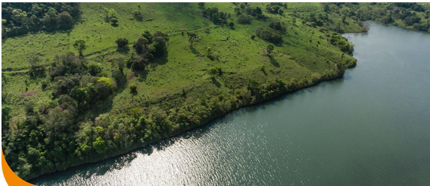
Represa Usina Hidrelétrica Foz de Chapecó
