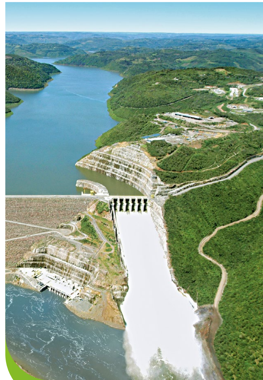
Usina Hidrelétrica Barra Grande
