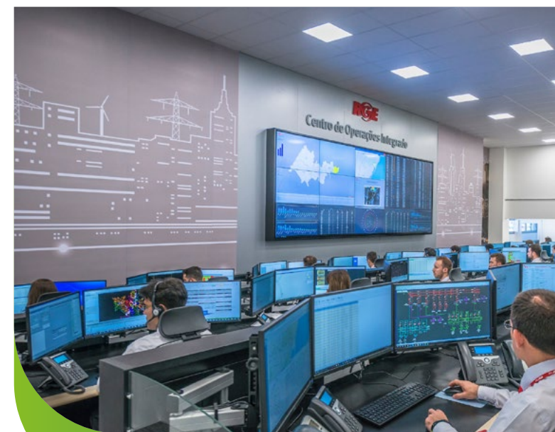
Centro de Operação Integrado em São Leopoldo - RS
