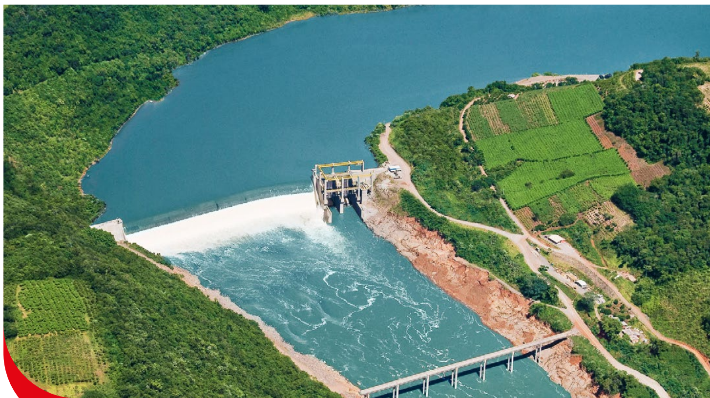
Usina Hidrelétrica 14 de Julho (CERAN)
