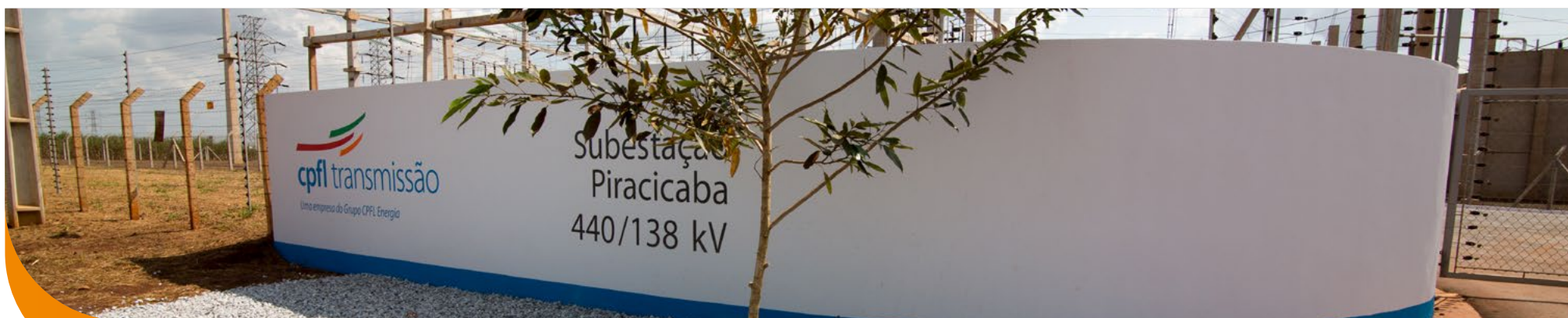
Subestação Piracicaba - SP
