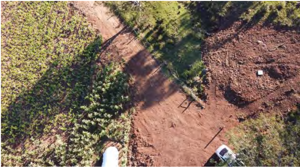
Melhoria em estrada interna (E17-2)
