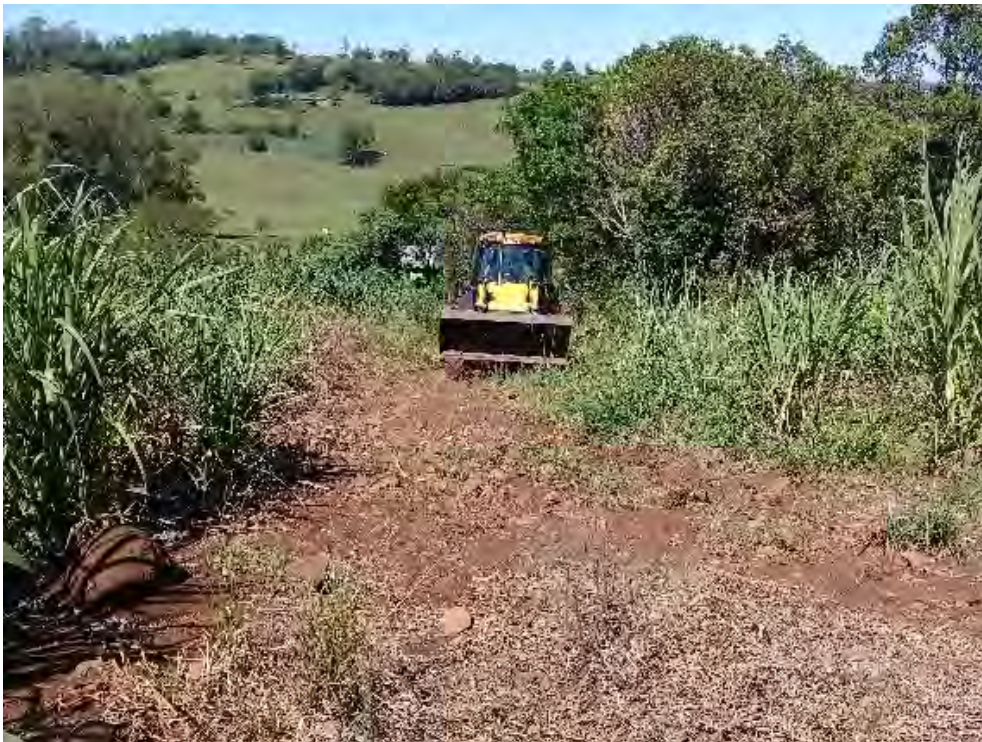
Melhoria de estrada interna (E17-2)
