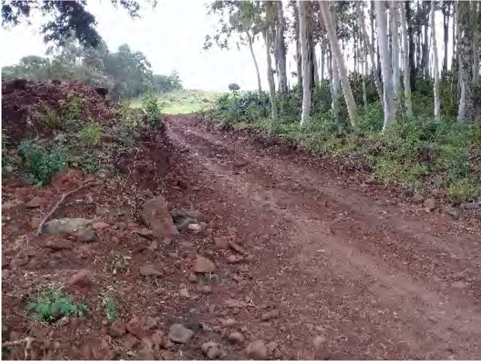
Melhoria de estrada interna (E12-2)
