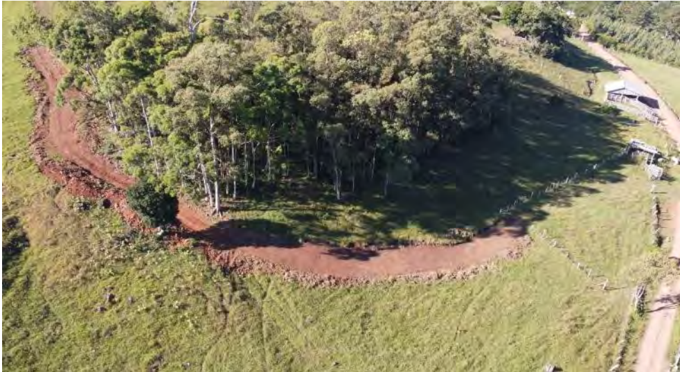
Melhoria em estrada interna (E12-2)
