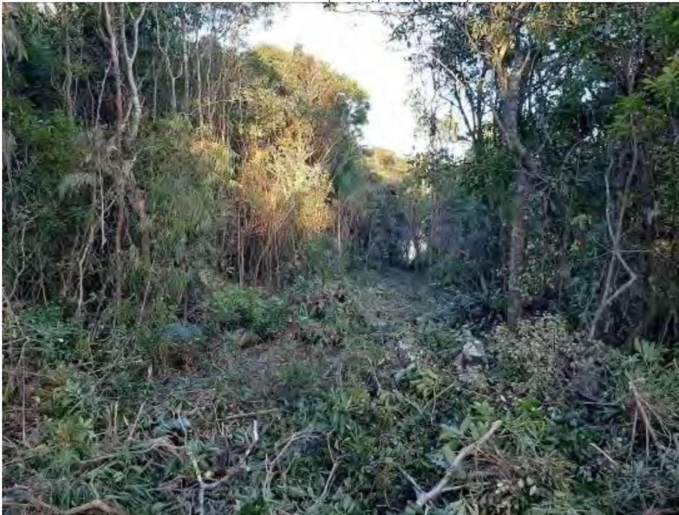
Limpeza de estrada colonial ára acessar a estrutura (E7-1)
