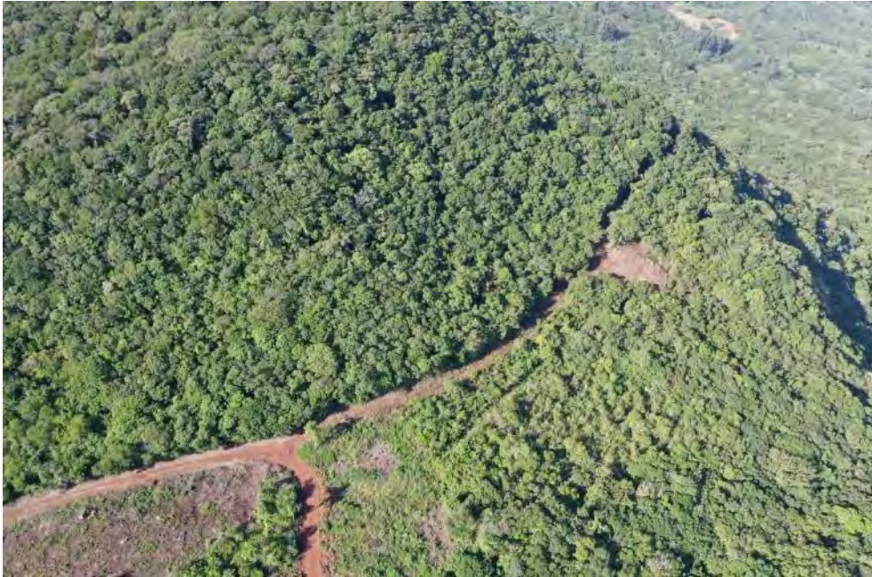
Estrada interna melhorada para acesso e supressão de área de torre (E7-2 e E7-1)
