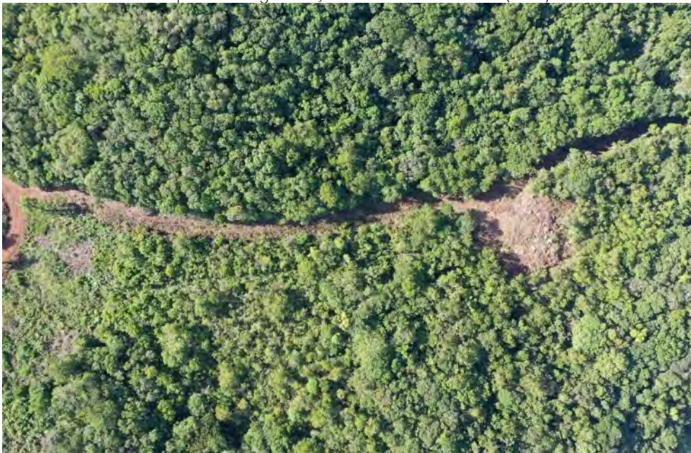
Estrada interna melhorada para acesso e supressão de área de torre (E7-2)
