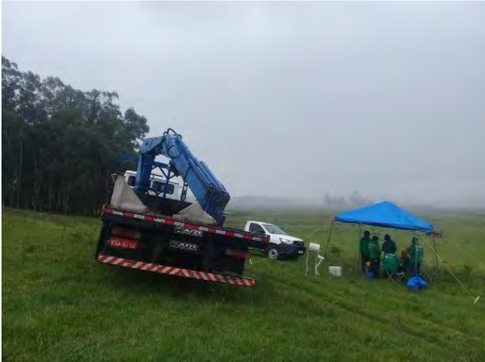
Acesso sobre pastagem ((E26-2)
