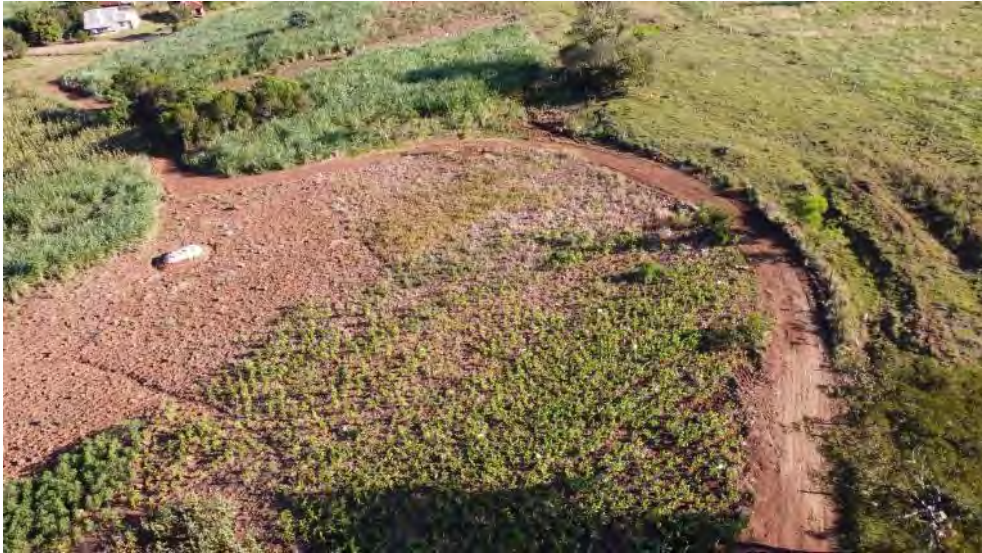
Melhoria em estrada interna (E17-2)
