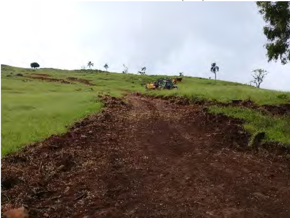
Melhoria de estrada interna (E12-2)
