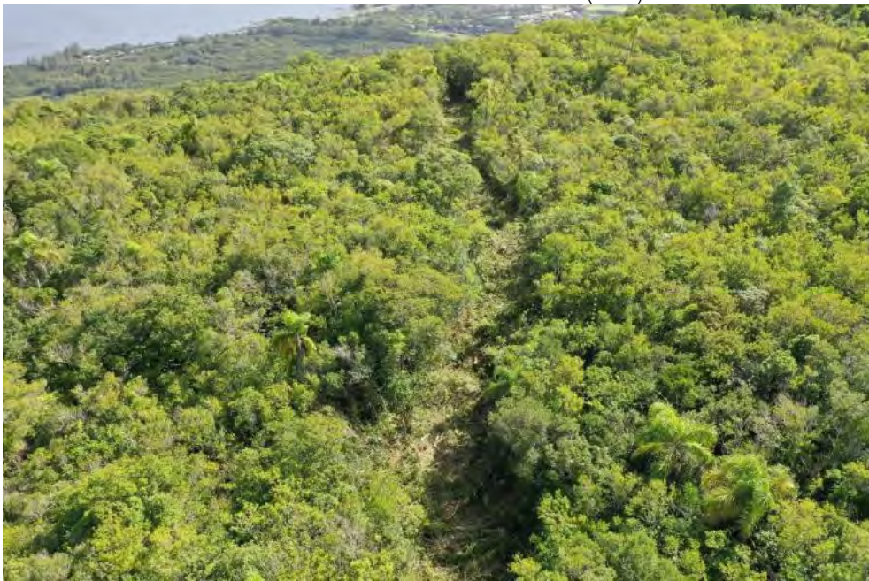
Supressão de vegetação para abertura de estrada (E8-1)
