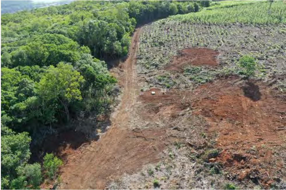
Uso de estrada interna sem danos (E7-3)
