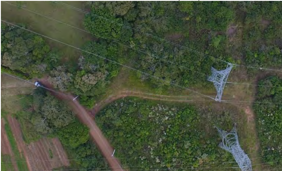
Acesso interno - supressão e abertura de acesso novo (E66-3)
