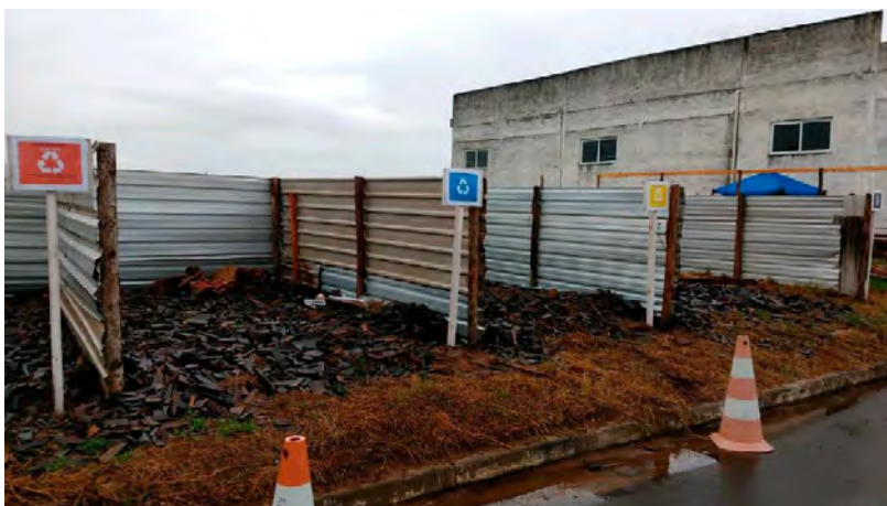
Foto 8 Caixas de segregação provisória de material no pátio de obras.
