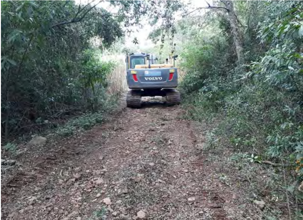
Melhoria em estrada interna (E3-3)
