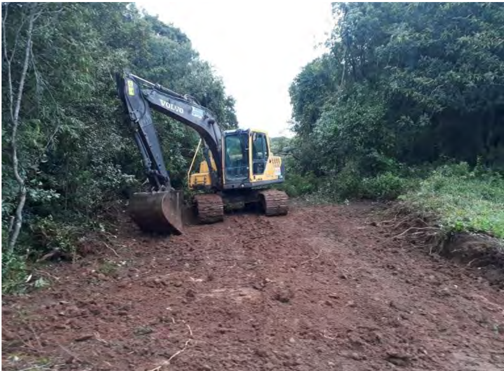
Melhoria em estrada interna (E3-3)
