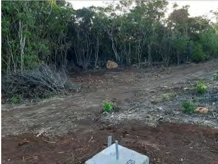
Foto 1 Área limpa após supressão e ordenamento.
