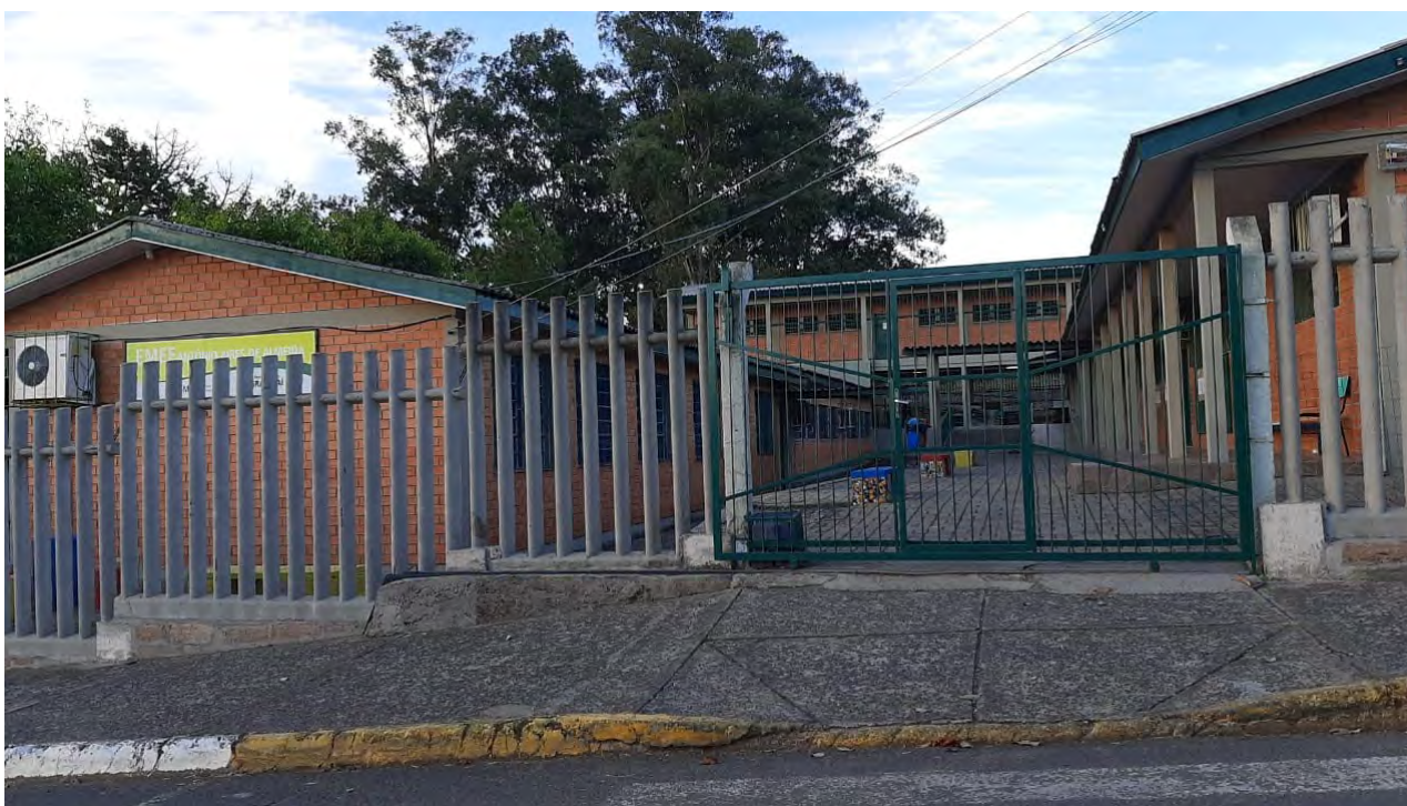
EMEF Antônio Aires de Almeida – Gravataí/RS (fechada)
