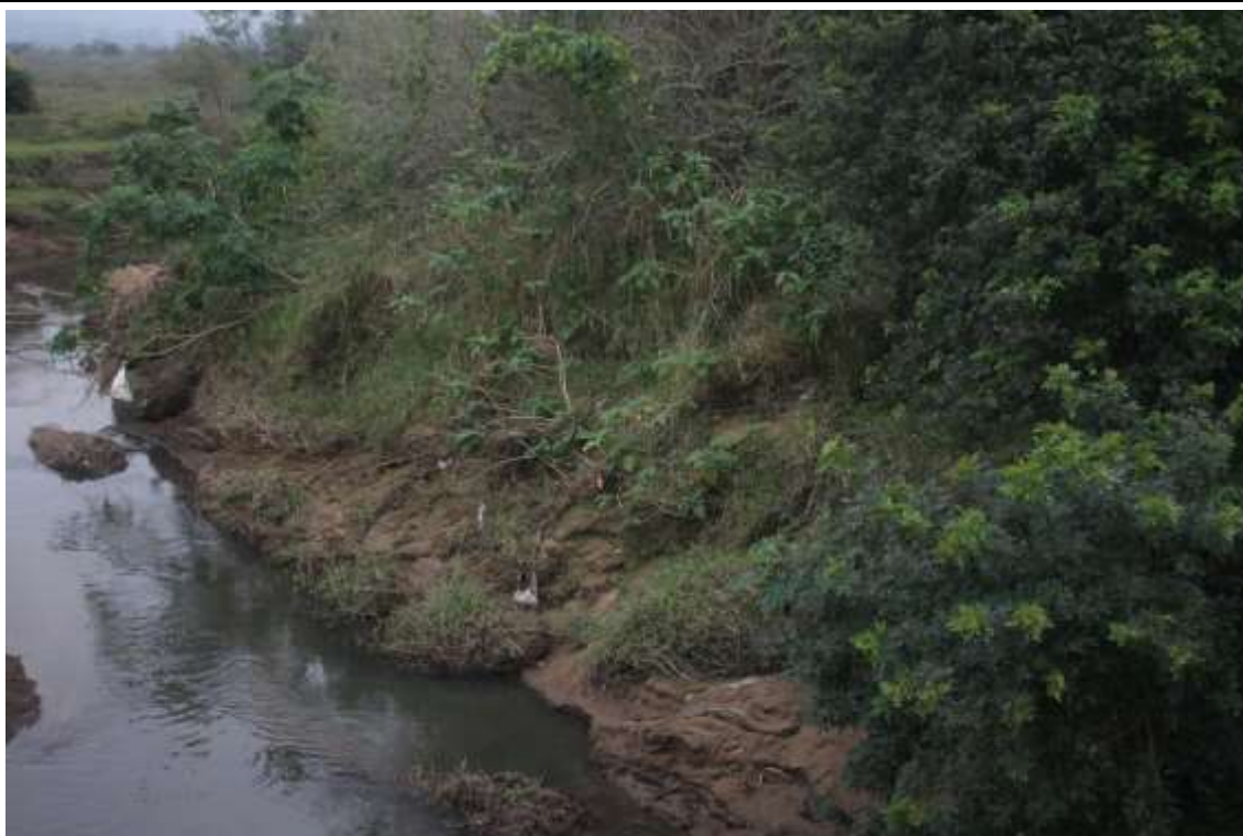
Figura 5.1-8 Exposição de talude as margens de drenagem.
