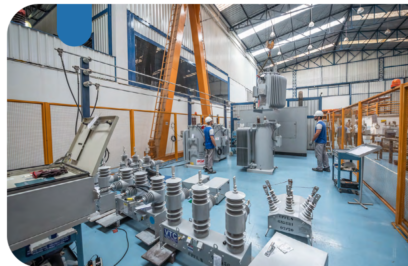
Reformadora de Equipamentos CPFL Energia
