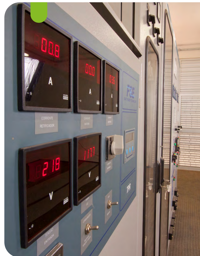
Usina de Biomassa
