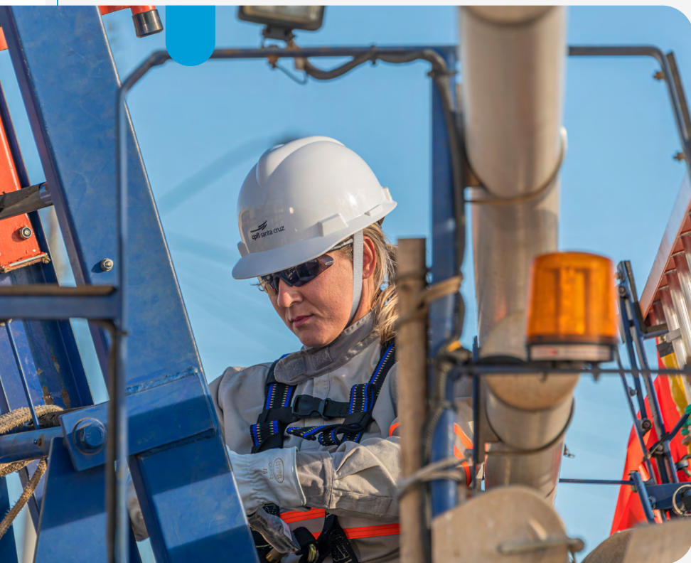
Colaboradora CPFL Energia
