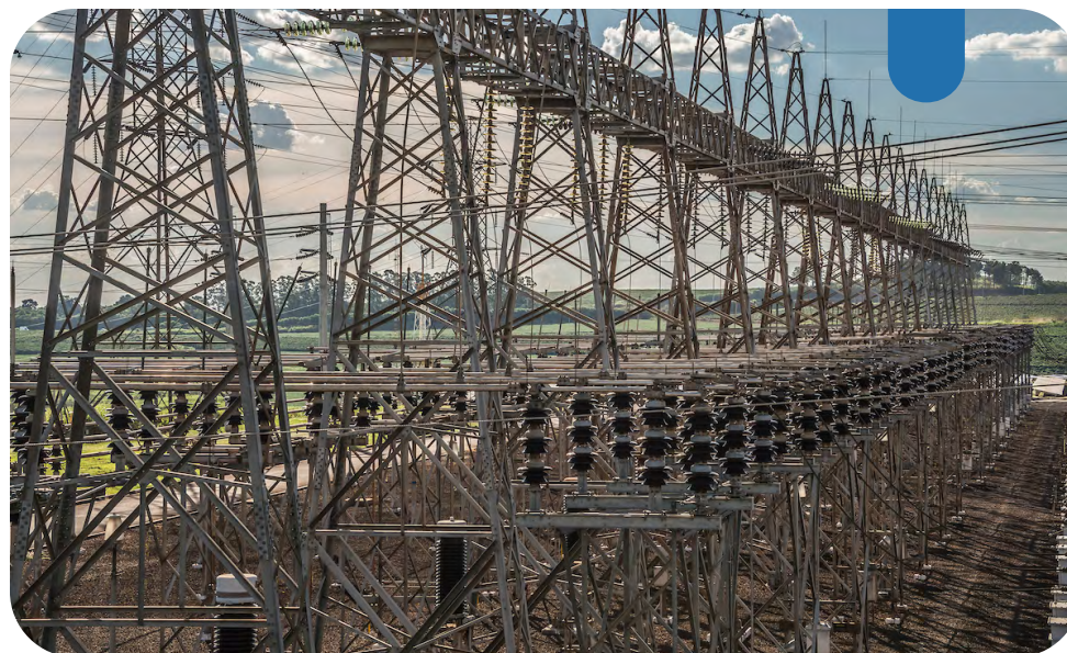
Subestação Tanquinho em Campinas - SP
