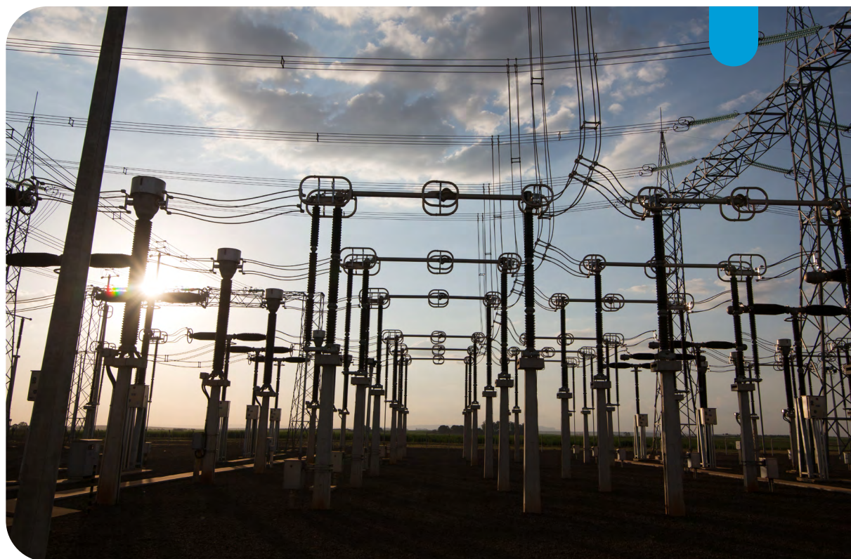
Subestação CPFL Transmissão Piracicaba
