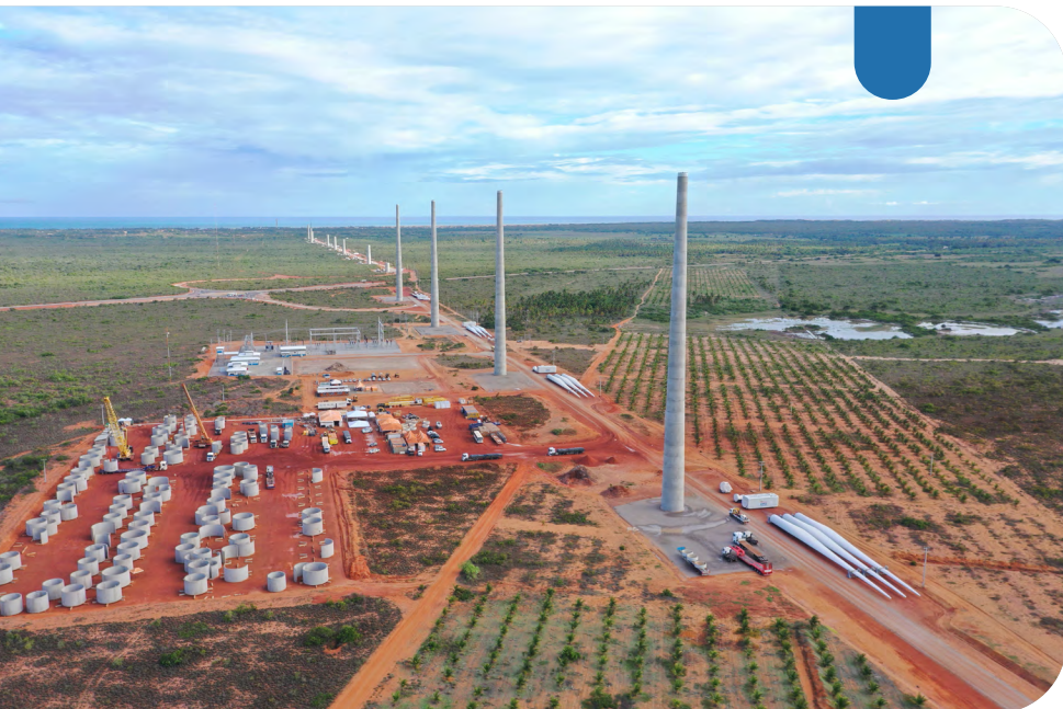
Construção do Complexo Eólico Gameleira - RN
