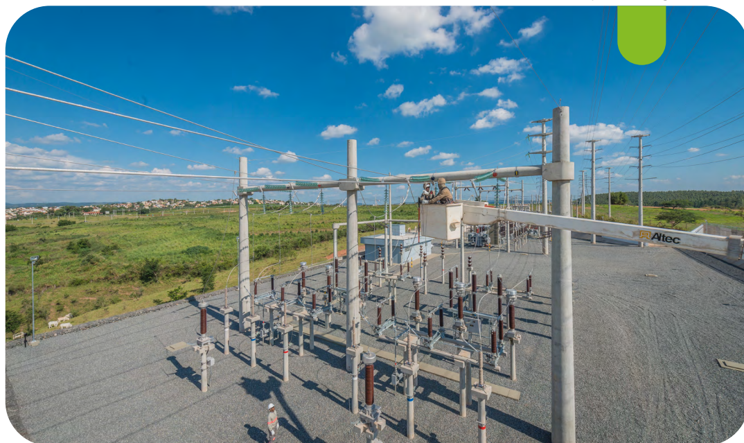
Subestação de energia
